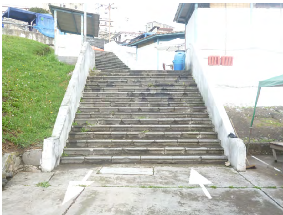
FIGURA 25: Circulación vertical sin rampas. Fuente: GAD Azogues 2021. Elaboración: El Autor.
