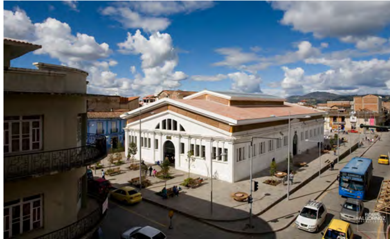
FIGURA 4: Rehabilitación del Mercado 9 de octubre: proyecto que manteniendo su forma y fachada original no genera un impacto agresivo con el contexto que lo rodea. Fuente: https://www.boraisalbornoz.com/mercado-9-de-octubre/ Recuperado: 20/04/2021
