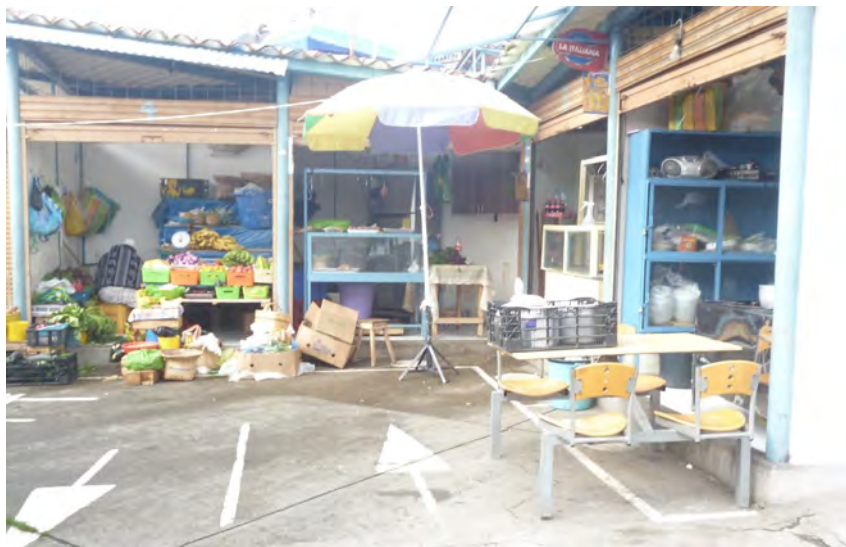
FIGURA 44: Puestos de venta fijos: puestos de venta construidos que expresan el uso, el deterioro, la invasión del espacio. Elaboración: El Autor.
