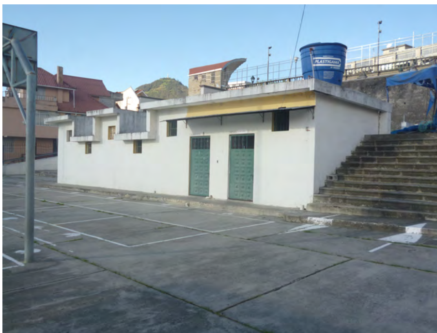
FIGURA 29: circulación vertical sin rampas. Fuente: GAD Azogues 2021. Elaboración: El Autor.
