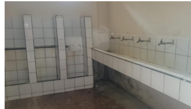
Fotografía N° 26. Interior Servicios Higiénicos. Fuente: Propia.
