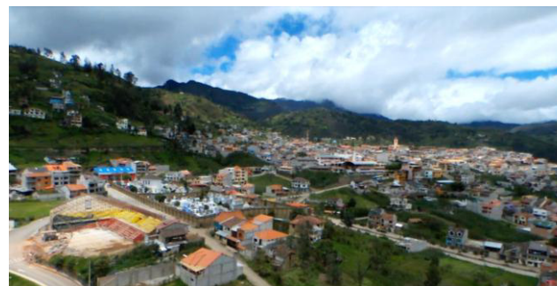
Fotografía N° 11. Vista aérea Sígsig. Fuente: Propia.
