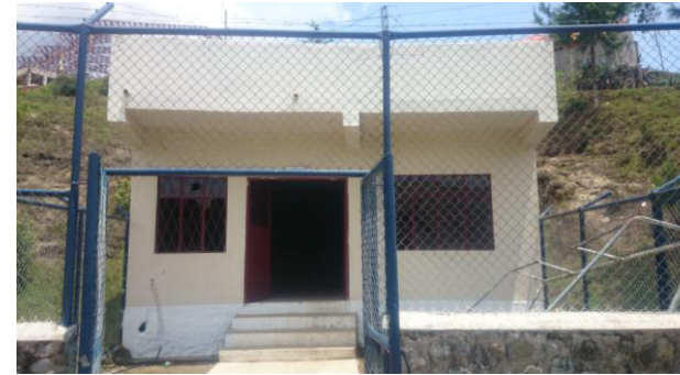
Fotografía N° 25. Fachada Bloque de Camerinos. Fuente: Propia.
