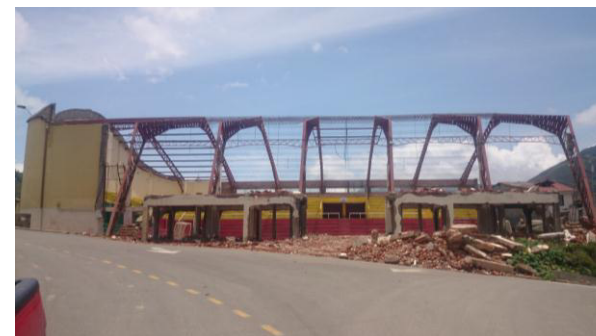
Fotografía N° 34. Coliseo en Proceso de Rediseño. Fuente: Propia.
