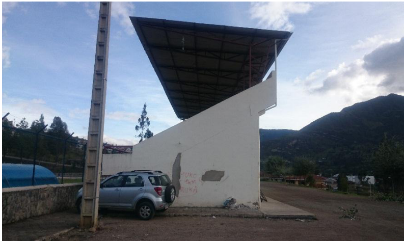
Fotografía N° 43. Vista Lateral Graderío Cubierto.
