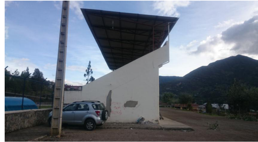
Fotografía N° 23. Graderío con Cubierta Oeste.
