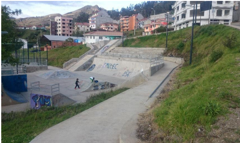
Fotografía N° 47. Vista Rampas Parque Extremo.
