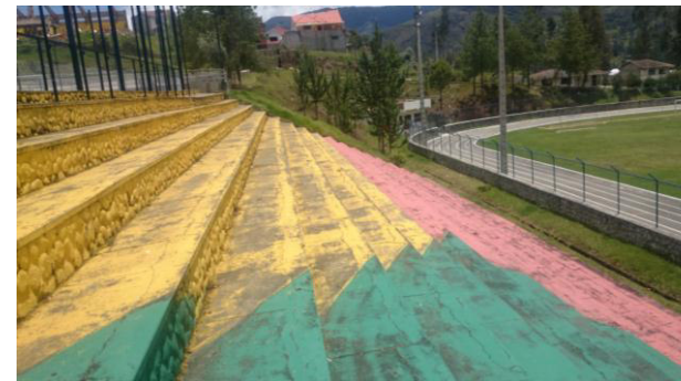
Fotografía N° 30. Graderío Oeste Exterior. Fuente: Propia.
