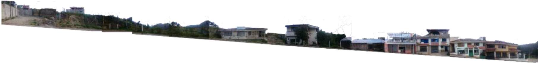
Fotografía N° 18. Vista Frontal de la Calle Luciano Pesántez.
