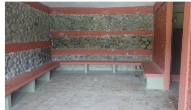
Fotografía N° 27. Interior banca en Camerinos. Fuente: Propia.
