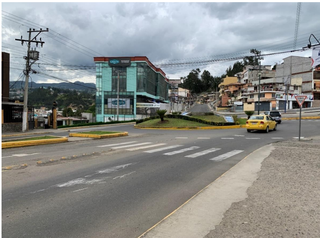
Imagen 54. Estado actual del cruce en la Av. 24 de mayo
