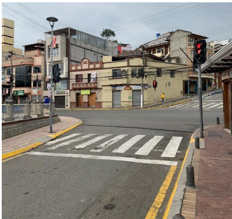
Imagen 49. Estado actual del cruce en la calle Simón Bolívar
