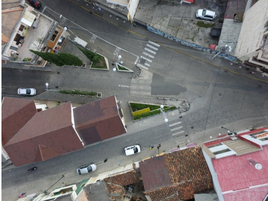
Imagen 37. Estado actual de la intersección I41
