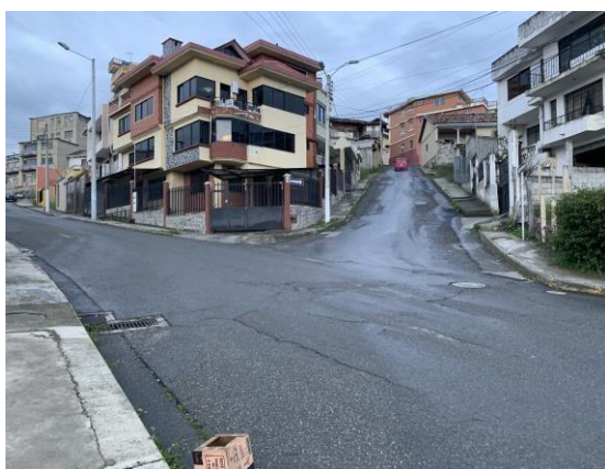
Imagen 11. Intersección entre la Av. Rumiñahui y la calle San Francisco y calle Ignacio de Veintimilla Nota. Autor de tesis
