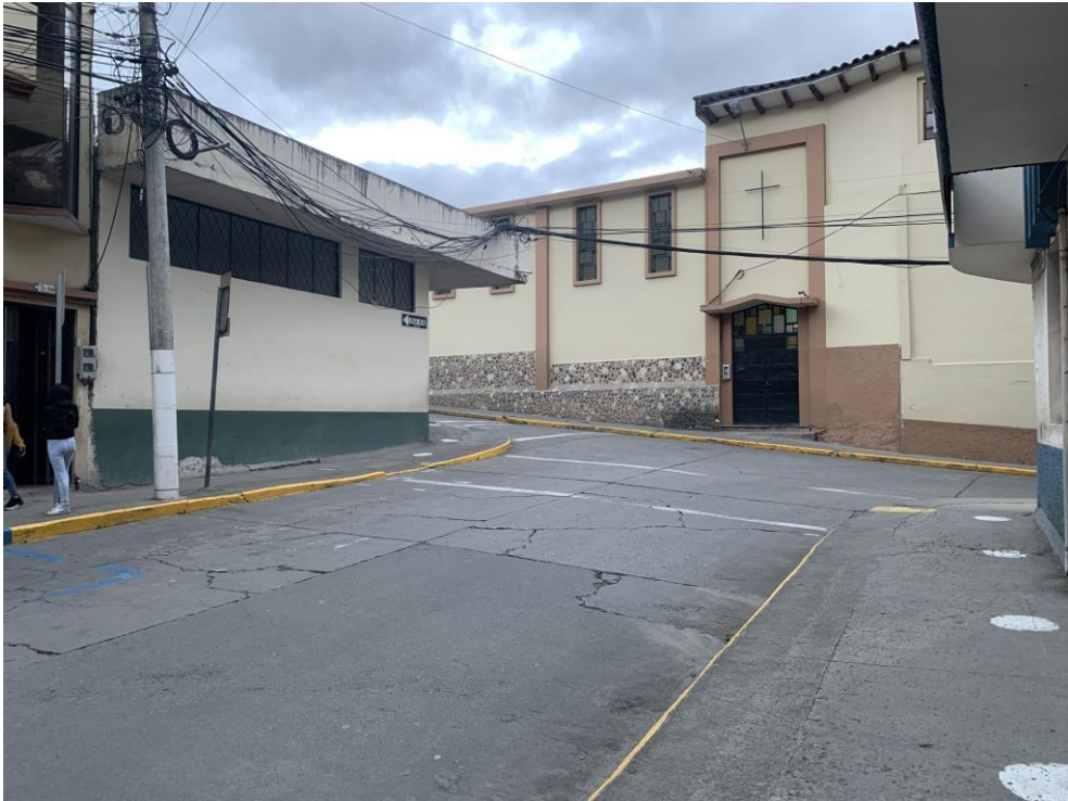
Imagen 36. Estado actual del cruce en la calle Ayacucho
