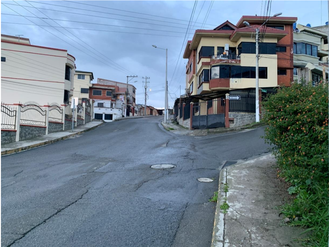
Imagen 24. Estado actual del cruce de la Av. Rumiñahui
