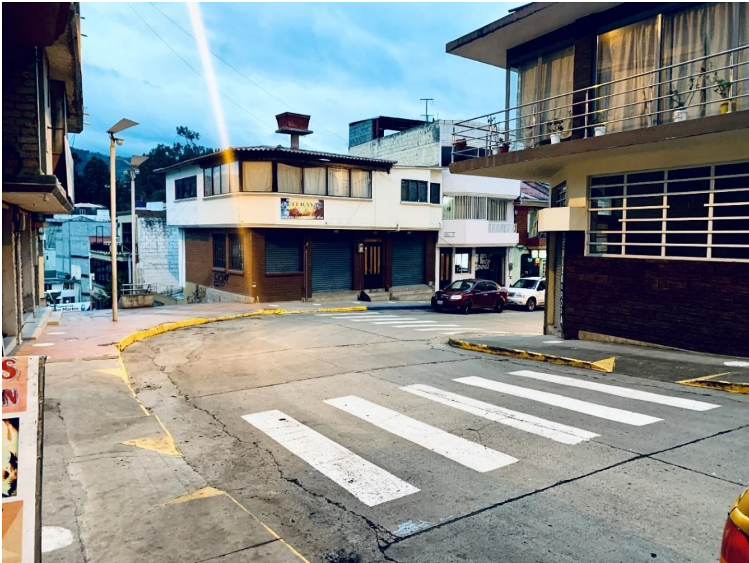
Imagen 21. Estado actual del cruce en la calle Luis Cordero
