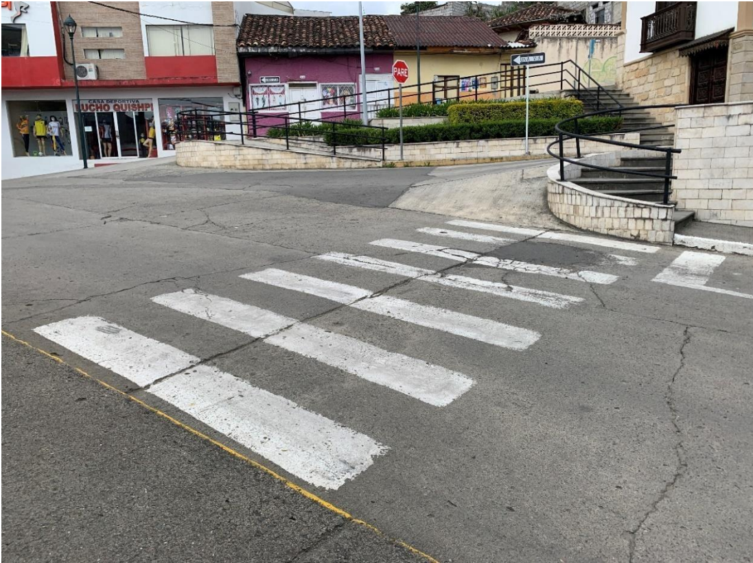
Imagen 38. Estado actual del cruce en la calle Emilio Abad
