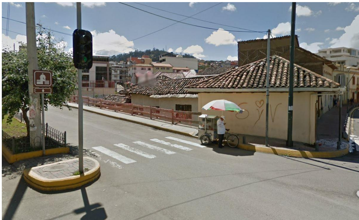
Imagen 50. Estado actual del cruce en la Av. Juan Bautista
