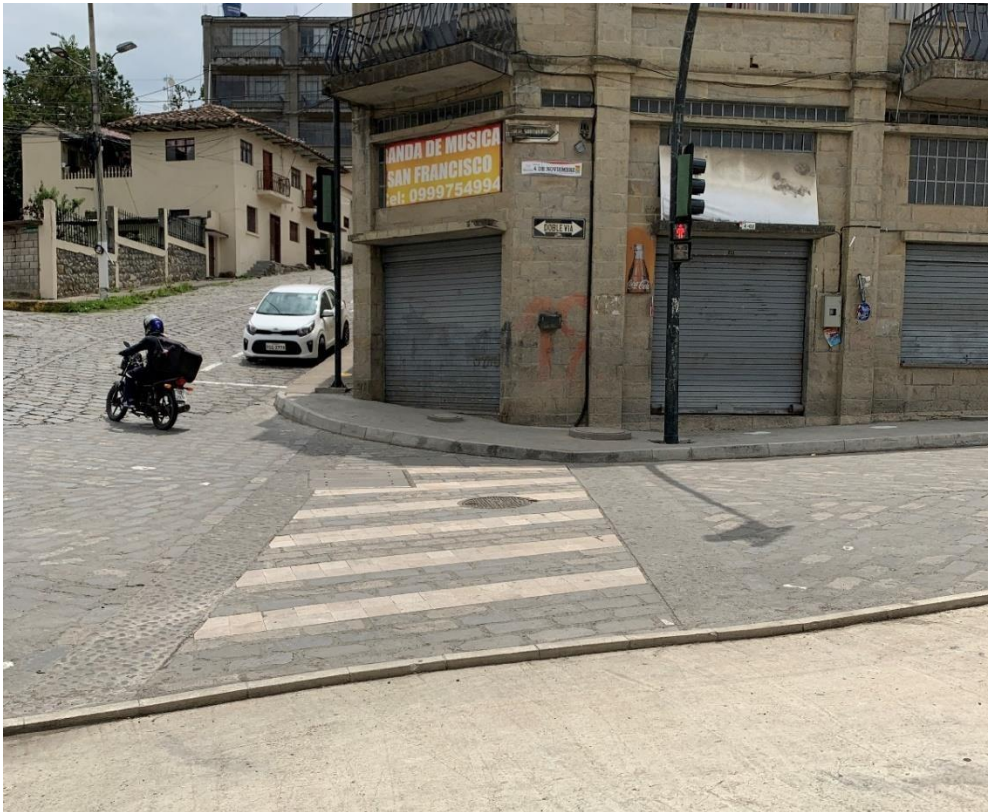
Imagen 45. Estado actual del cruce en la calle Atahualpa
