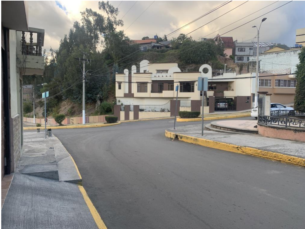
Imagen 30. Estado actual del cruce en la calle Benigno Malo
