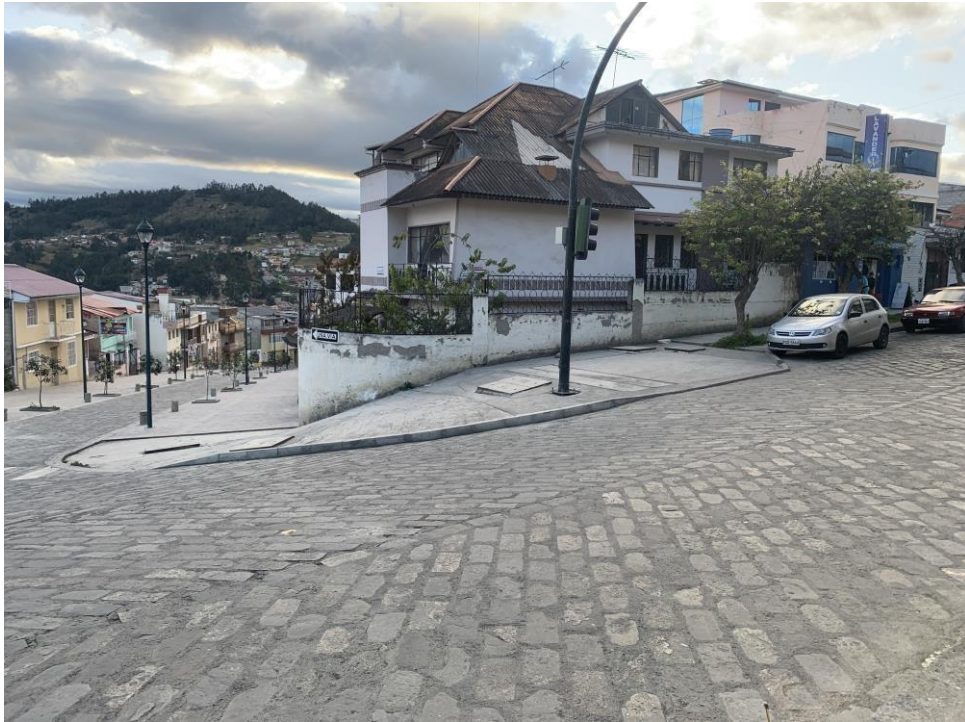
Imagen 46. Estado actual del cruce en la calle 4 de noviembre
