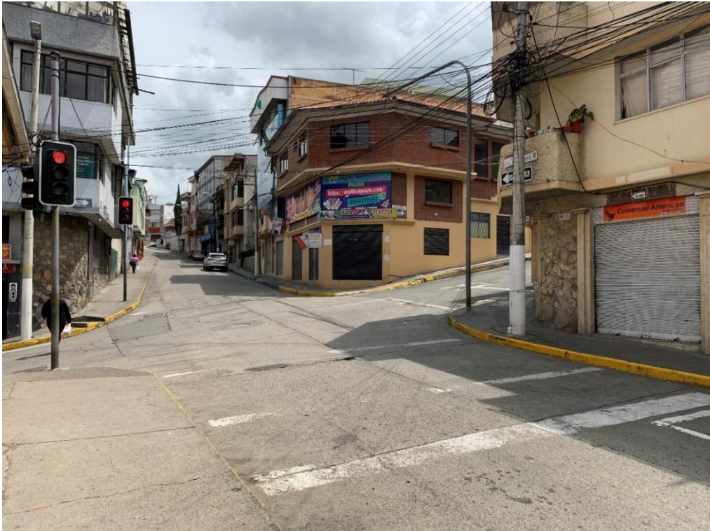
Imagen 33. Estado actual del cruce en la calle Emilio Abad
