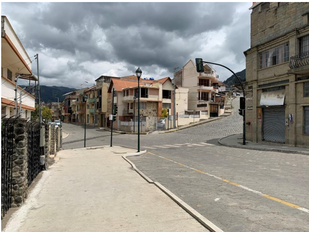
Imagen 44. Estado actual del cruce en la calle Atahualpa
