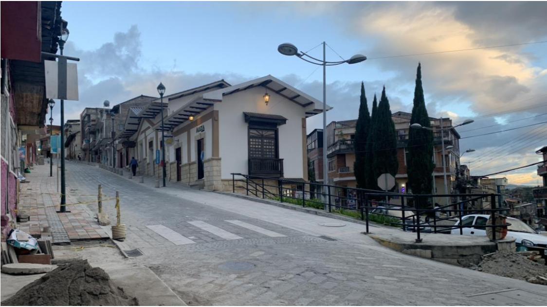
Imagen 39. Estado actual del cruce de la Av. de la Virgen
