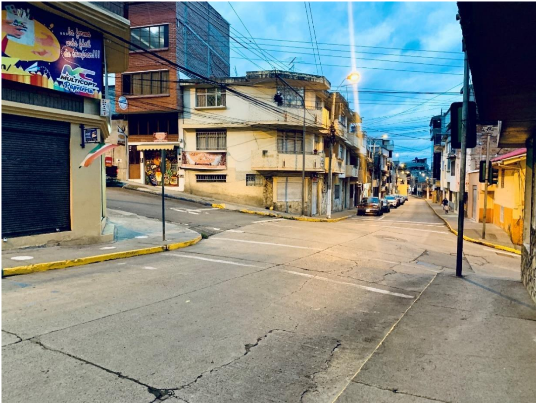
Imagen 32. Estado actual del cruce en la calle Emilio Abad
