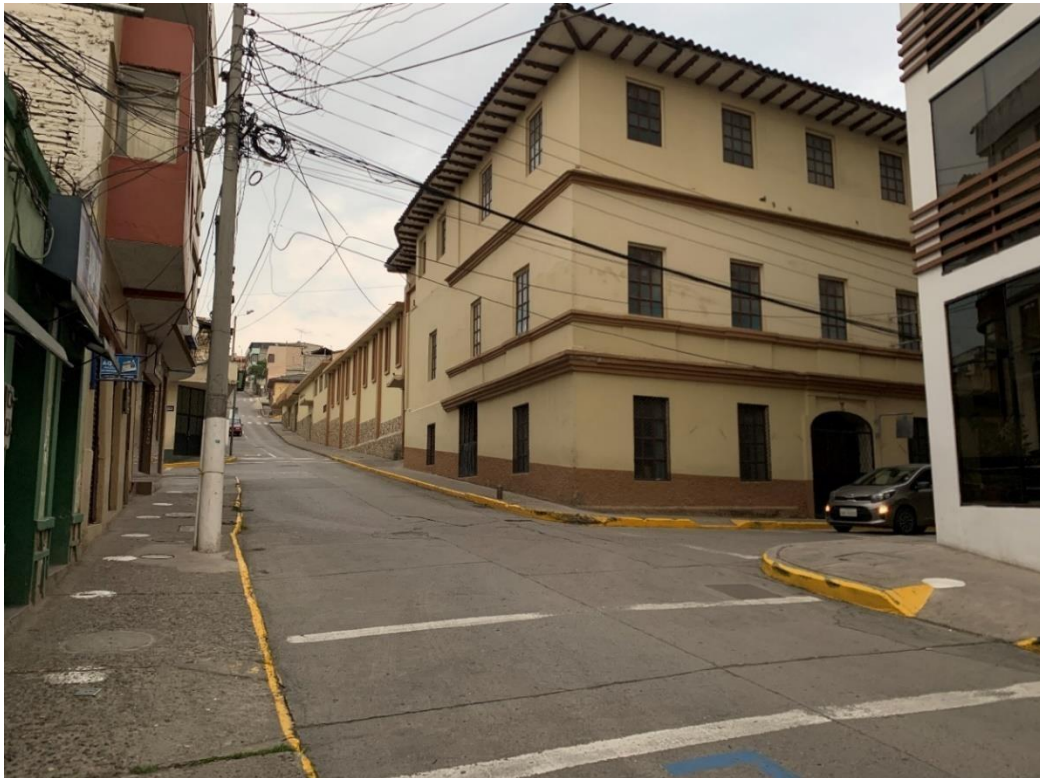
Imagen 35. Estado actual del cruce en la calle Bartolomé Serrano
