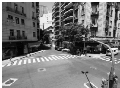
Imagen 5. Intersección antes de la intervención.
