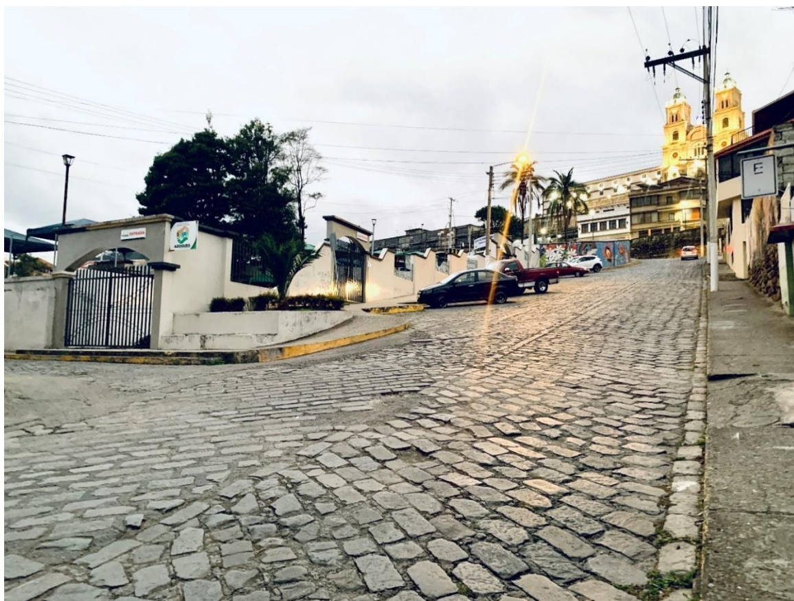
Imagen 25. Estado actual del cruce en la calle Atahualpa
