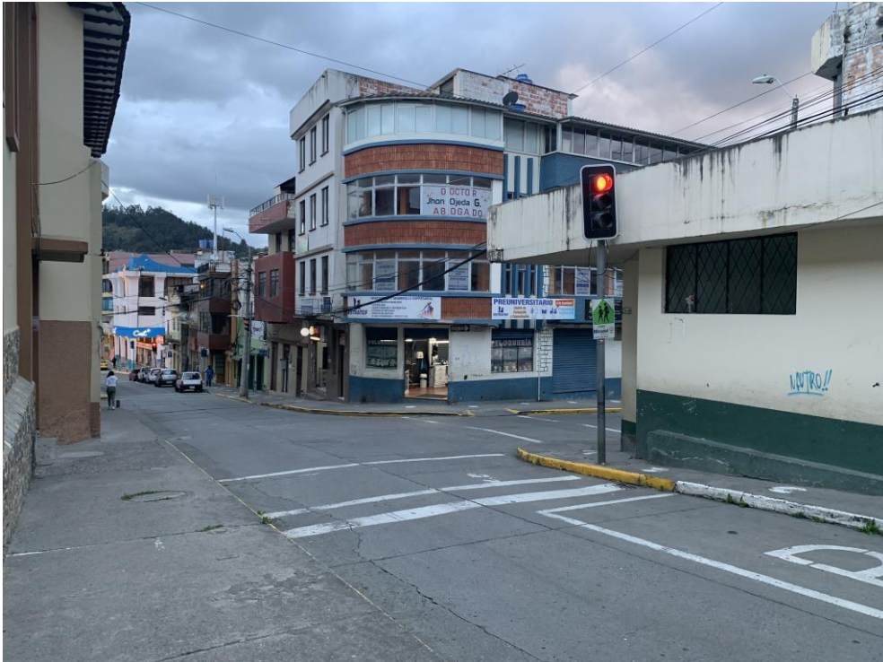
Imagen 34. Estado actual del cruce en la calle Bartolomé Serrano
