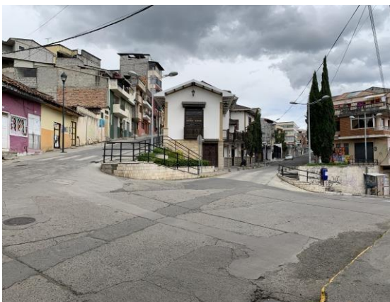
Imagen 16. Intersección entre la calle Emilio Abad, Av. de la Virgen y calle José Joaquín de Olmedo
