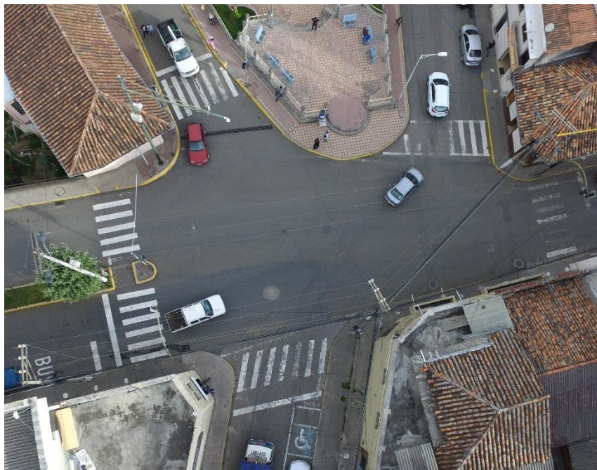
Imagen 47. Estado actual de la intersección I2
