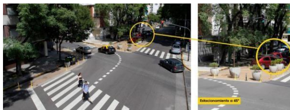
Imagen 4. Intersección después de la intervención.
