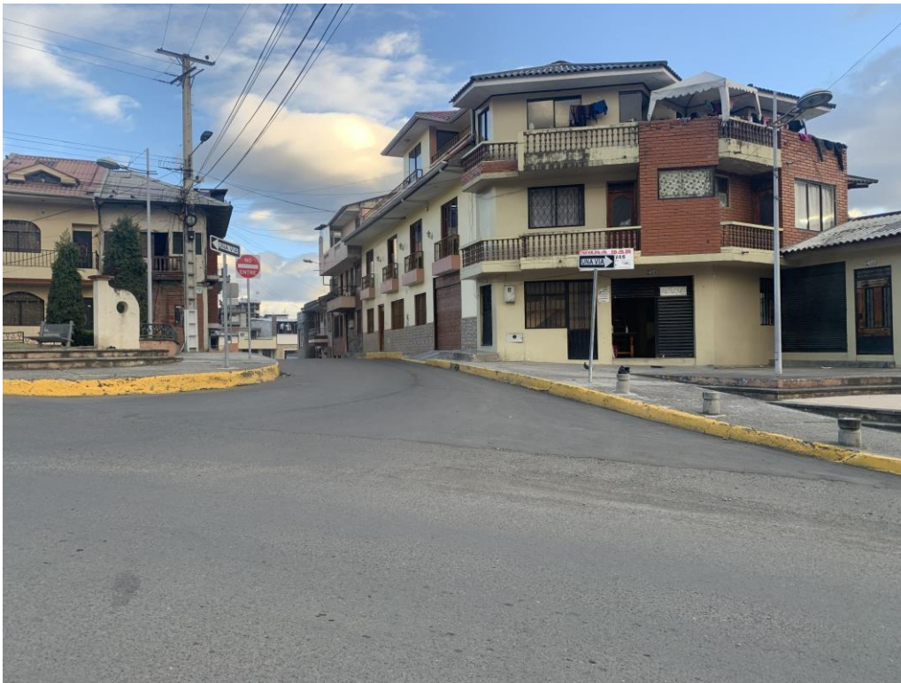
Imagen 31. Estado actual del cruce en la calle Benigno Malo
