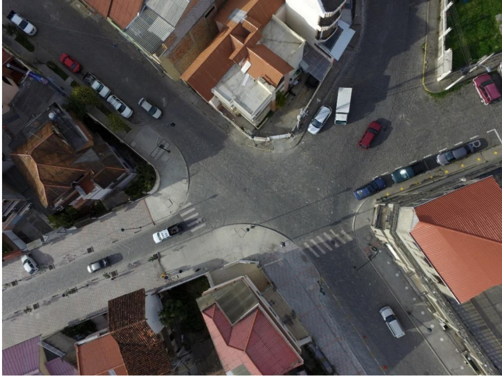
Imagen 42. Estado actual de la intersección I61
