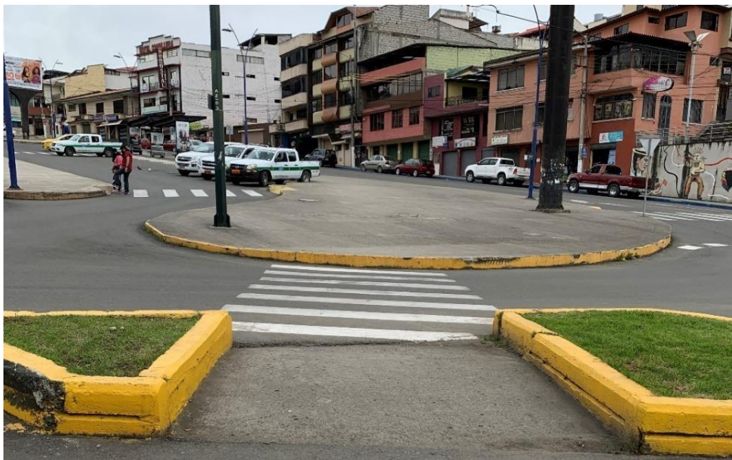
Imagen 55. Estado actual del cruce en la Av. 24 de mayo
