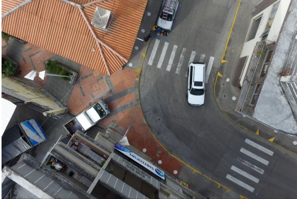
Imagen 20. Estado actual de la intersección I7
