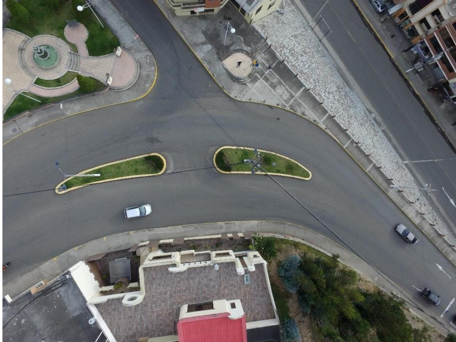
Imagen 28. Estado actual de la intersección II
