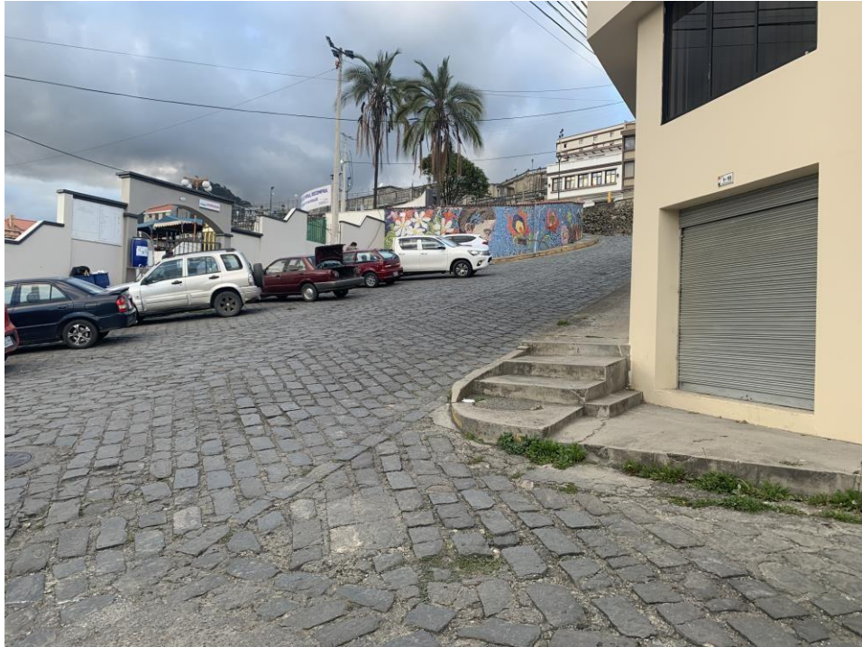
Imagen 26. Estado actual del cruce en la calle Atahualpa
