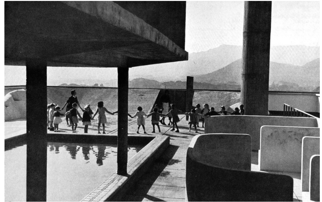
8 Img. Edificio de Marsella 1952
