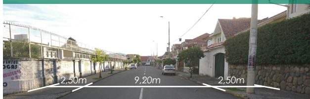
66 Img. Vialidad Calle Altar Urco | Tipo: Local | Una vía | Señalización: Si
