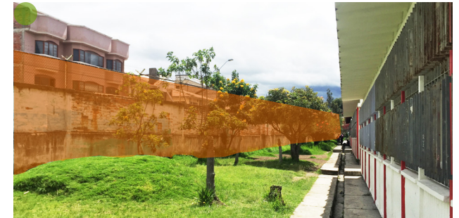
63 Img. Aulas frente a los muros.
