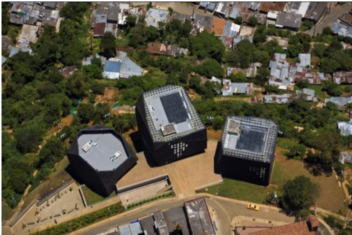
Figura 1: Caso de regeneración urbana con impacto social y espacial: Parque Biblioteca España, Medellín.
