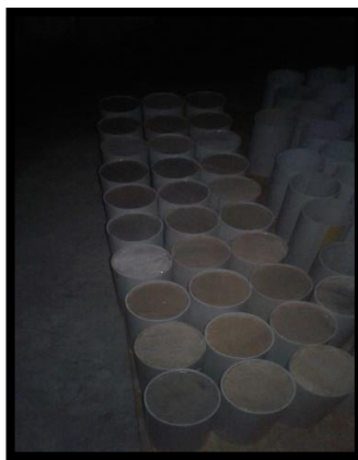
Foto 13.- Fase 3 - Acople de tapas con los tubos e impermeabilización (Fuente: Autor)
