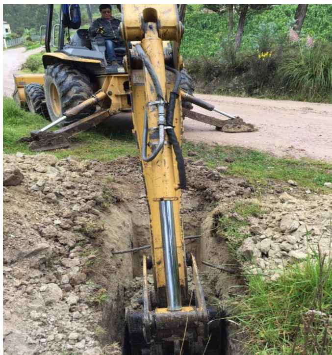
Fotografía 4. Extracción a máquina de las muestras tomadas.
