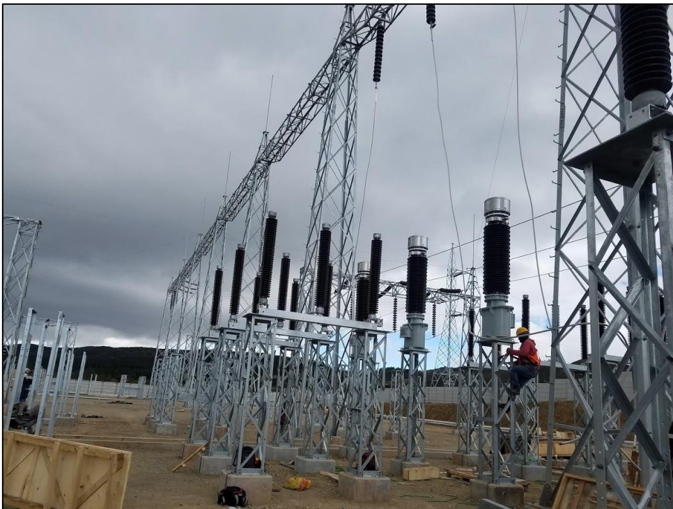
Fig. 9 Ejemplo de pórticos de doble juego de barras en 138kV S/E La Paz.
