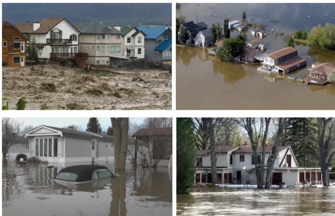
FIGURA 1.15: Imágenes de viviendas afectadas
