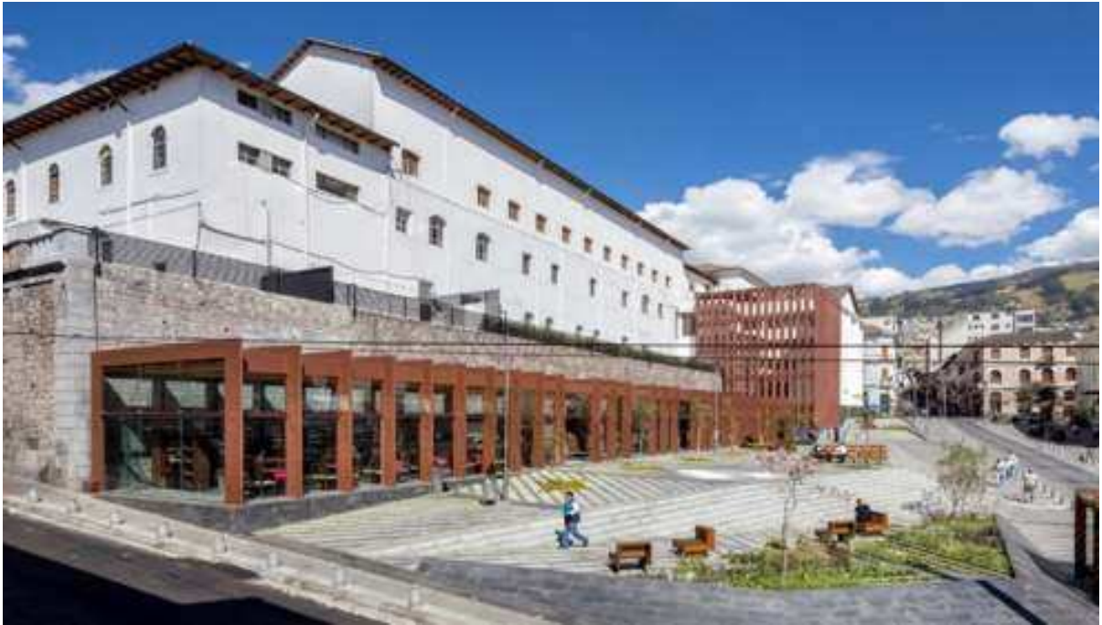
FIGURA 1.9: Plaza Huerto San Agustín. Fuente: ArchDaily. https://www.archdaily.cl/cl/798793/plaza-huerto-san-agustin-jaramillo-van-sluyss-arquitectura-plus-urbanismo
