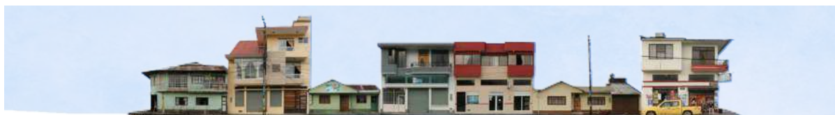
FIGURA 2.43: Tramo 2. Elaboración: propia
