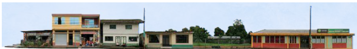
FIGURA 2.42: Tramo 1. Elaboración: propia
