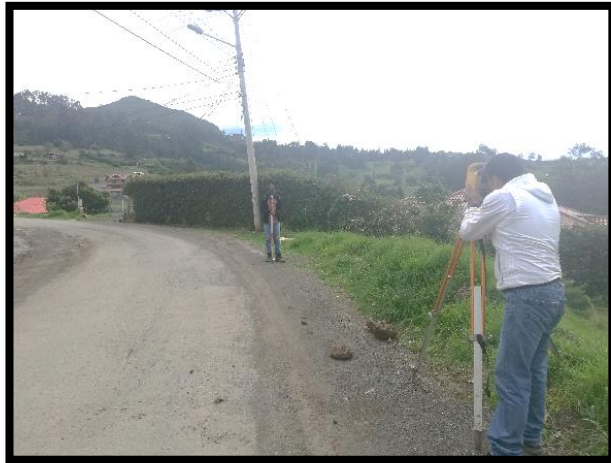
Foto N° 19 Colocación de estación Total Referencia 15. Fuente: Christian Romero, Cuenca, 2020.
