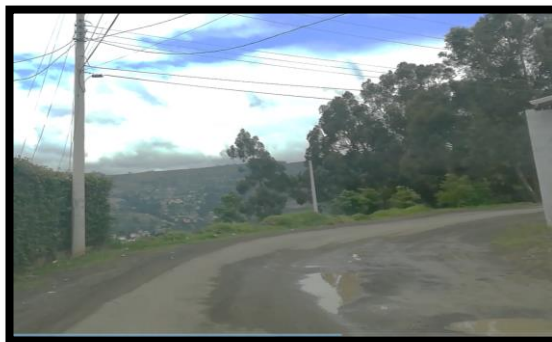
Foto N° 14 Falta de señalización. Fuente: Christian Romero, Cuenca, 2020.
