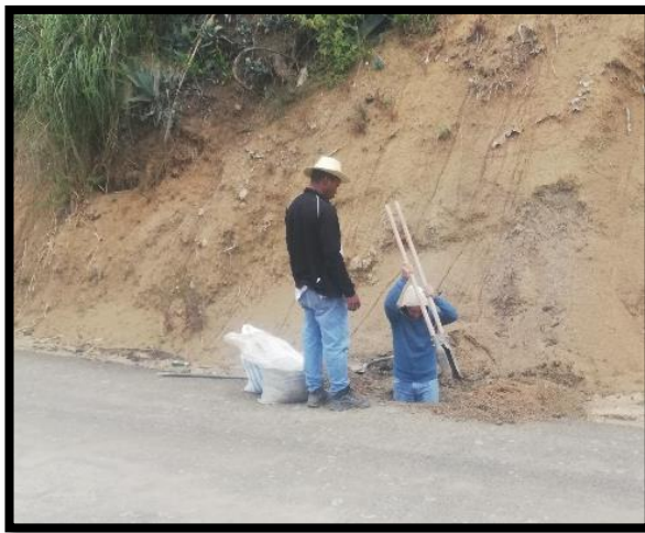
Foto N° 21 Excavación de calicatas. Fuente: Christian Romero, Cuenca, 2020.
