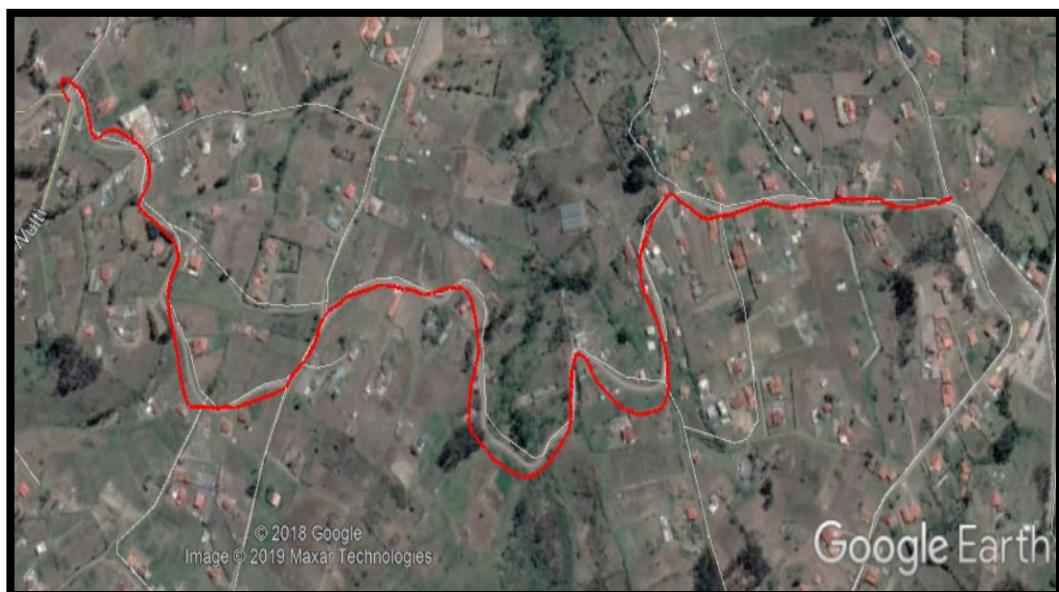
Foto N° 1 Vista Aérea del proyecto a ser evaluado. Fuente: Google Earth.
