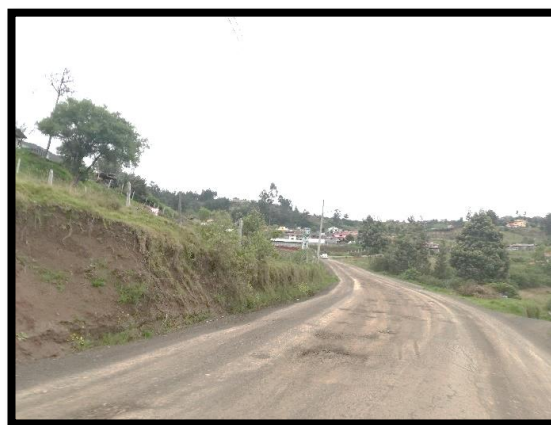
Foto N° 20 Ubicación de la estación del aforo vehicular. Fuente: Christian Romero, Cuenca, 2020.
