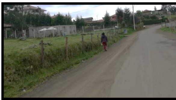
Foto N° 9 Estado Actual de la vía. Fuente: Christian Romero, Cuenca, 2020.
