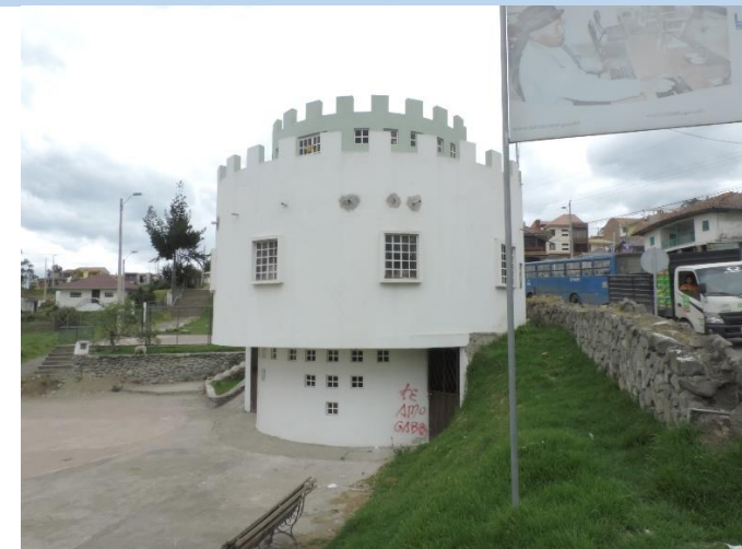
Foto 22: Edificación existente. Fuente: Edwin Ochoa – Elaboración: Edwin Ochoa.
