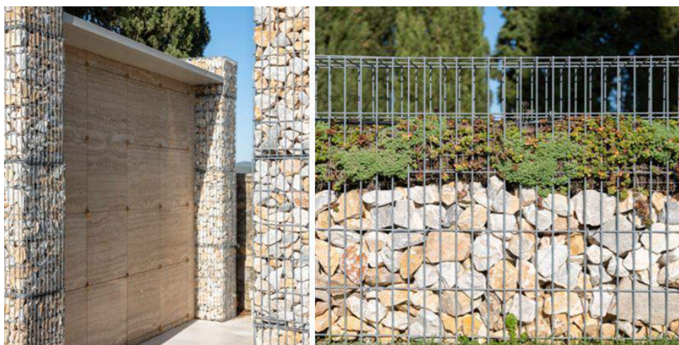
FIGURA 2.9: Materiales de las estructuras - cementerio Castel San Gimignano. Fuente:Pintos(2020).
