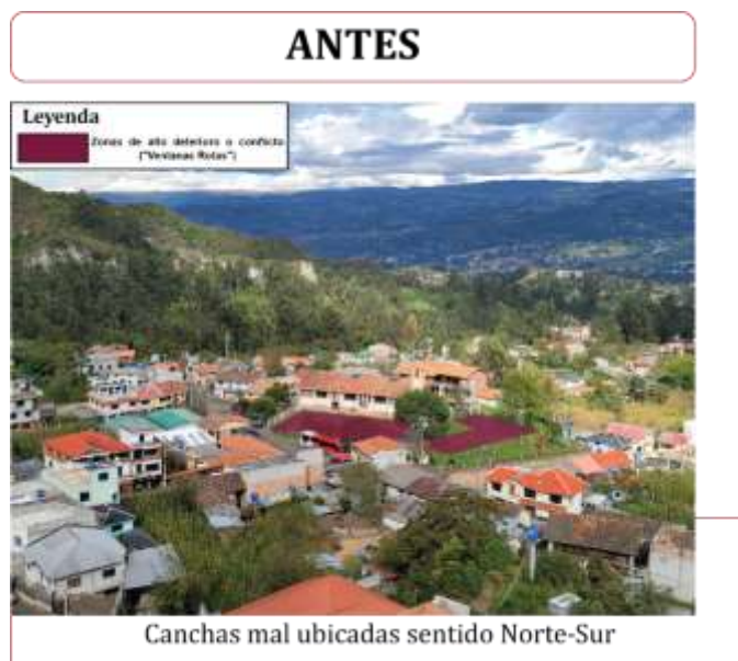
Figura 72: Canchas mal ubicadas sentido Norte-Sur
