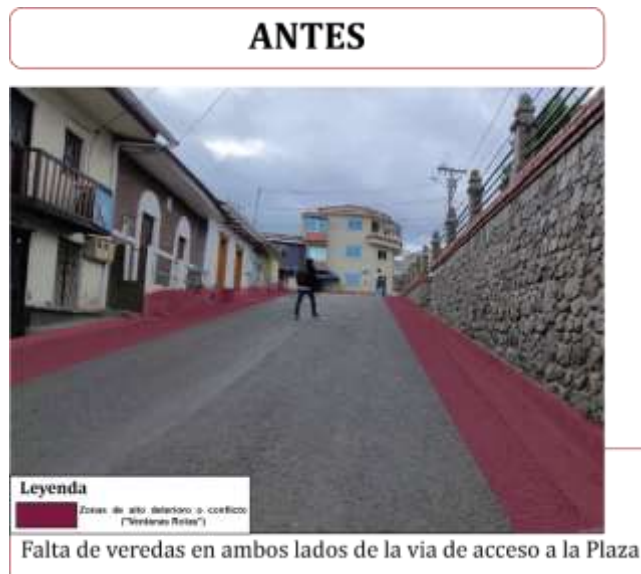
Figura 71: Ausencia de veredas Alrededor de la Plaza acceso principales.
