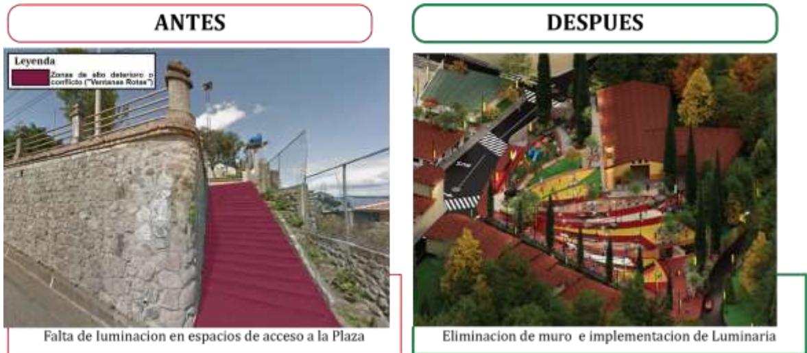
Figura 144: Muro de piedra antes de rehabilitación (barrera visual – inseguridad).
