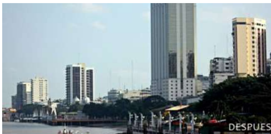
Figura 39: Malecón Simón Bolívar como Malecón 2000, después de su rehabilitación (2000)
