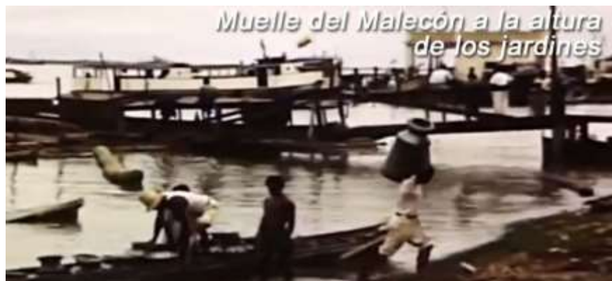
Figura 38: Malecón Simón Bolívar (Guayaquil), estado deteriorado (circa 1995-1999)
