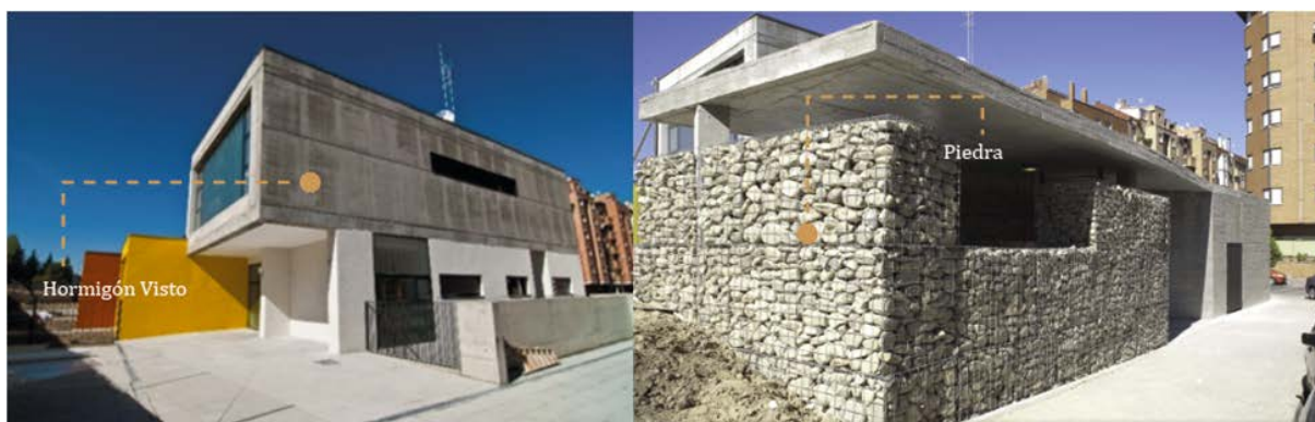
FIGURA 2.4: Aplicación de texturas en el exterior de Aleph Tea. Fuente: ALEPH-TEA Special Education School. Recuperado de: https://archello.com/project/aleph-tea-special-education-school . Elaboración: propia.
