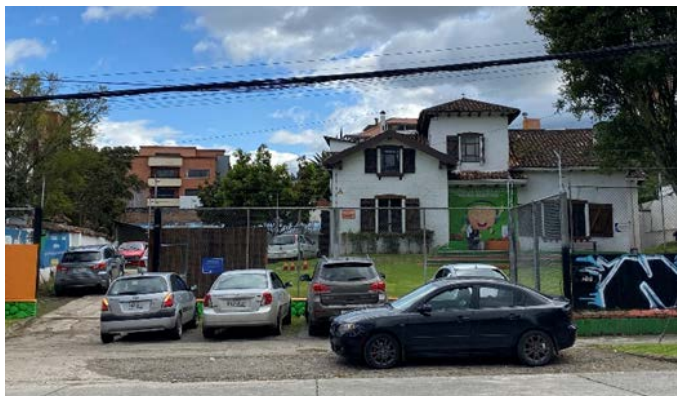
FIGURA 2.13: Fachada Centro Terapéutico Tomatis
