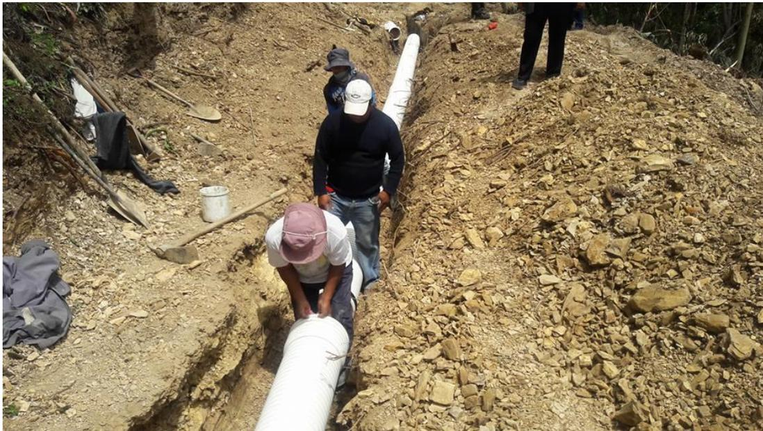
**Figura 31.** Reparación de una tubería plástica de PVC. Fuente: GADPC
