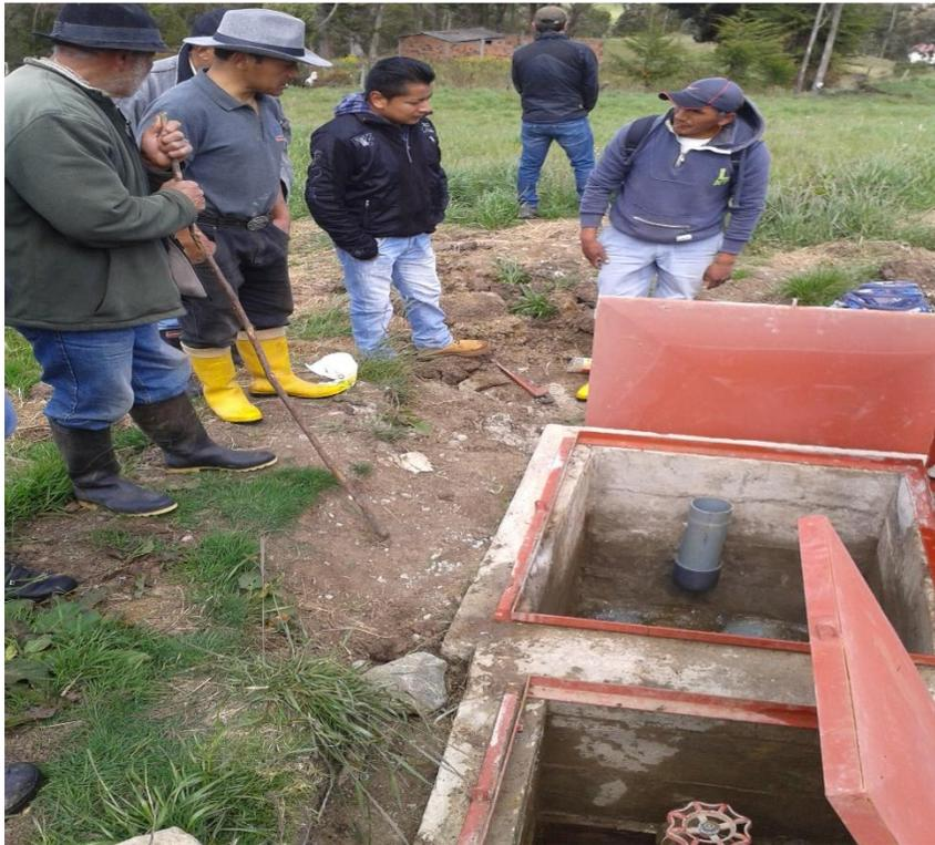
**Figura 30.** Limpieza del tanque rompe presión. Fuente: GADPC
