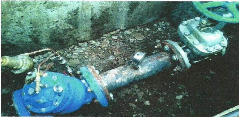
Figura 11. Válvula reguladora de presión. Fuente GADPC.
