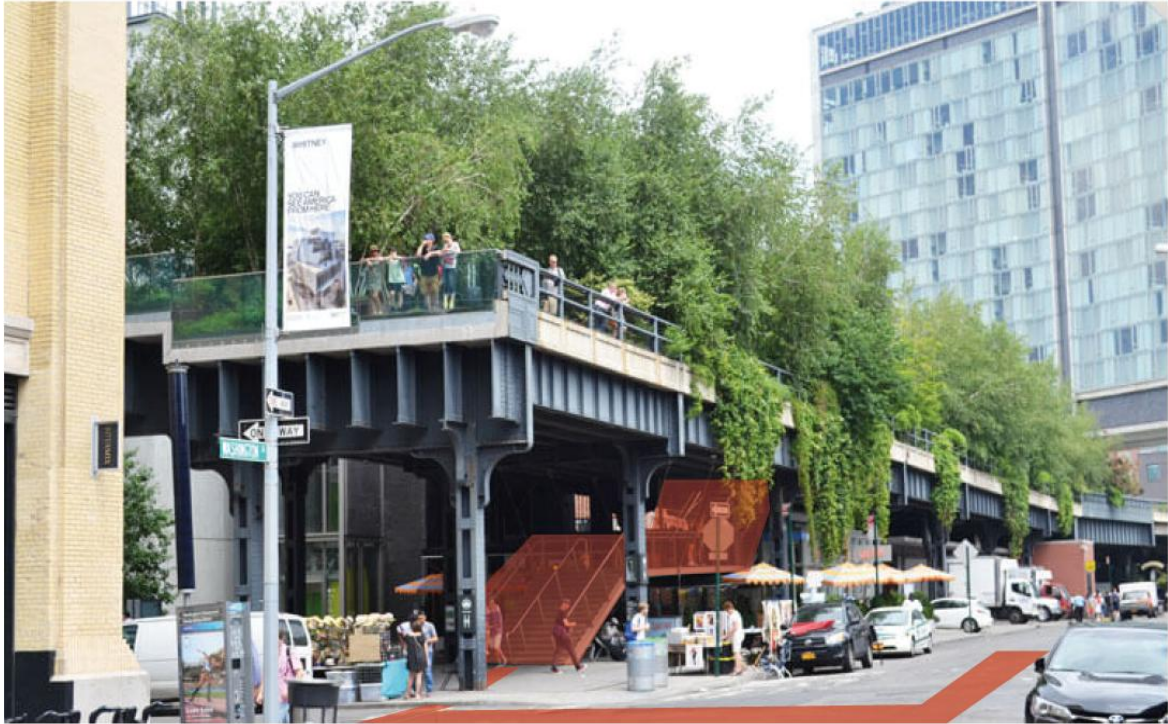
Figura 15. Acceso. High Line, New York. Tomada de Par Caro (2022). Elaboración propia (2025).
