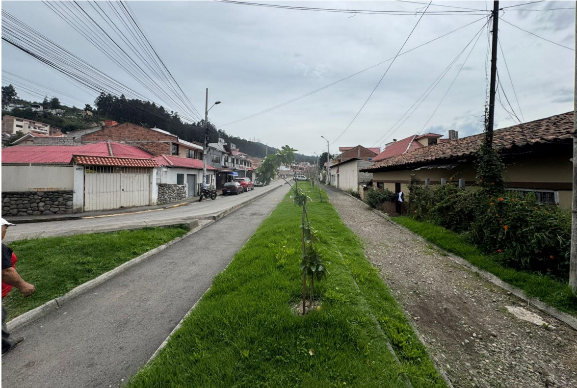
Figura 101. Tramo 9 actual. Corredor Verde de Gapa. Elaboración propia (2026).
