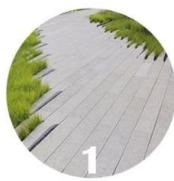
1 Concreto y Adoquines
