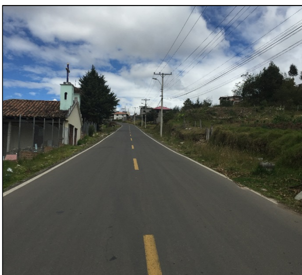
Foto 43: Vía Asfaltada Frente al Terreno
