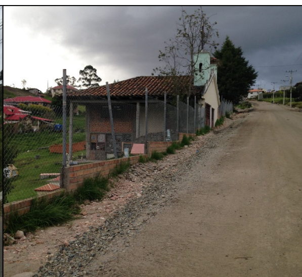
Foto 44: Vía sin asfaltar frente al terreno
