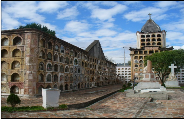
Imagen N°36: Bloques internos del Cementerio Patrimonial Municipal de Cuenca
