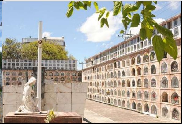
Imagen N°37: Bloques internos del Cementerio Patrimonial Municipal de Cuenca
