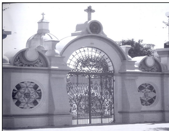
Imagen N°35: Mantenimiento del cerramiento
