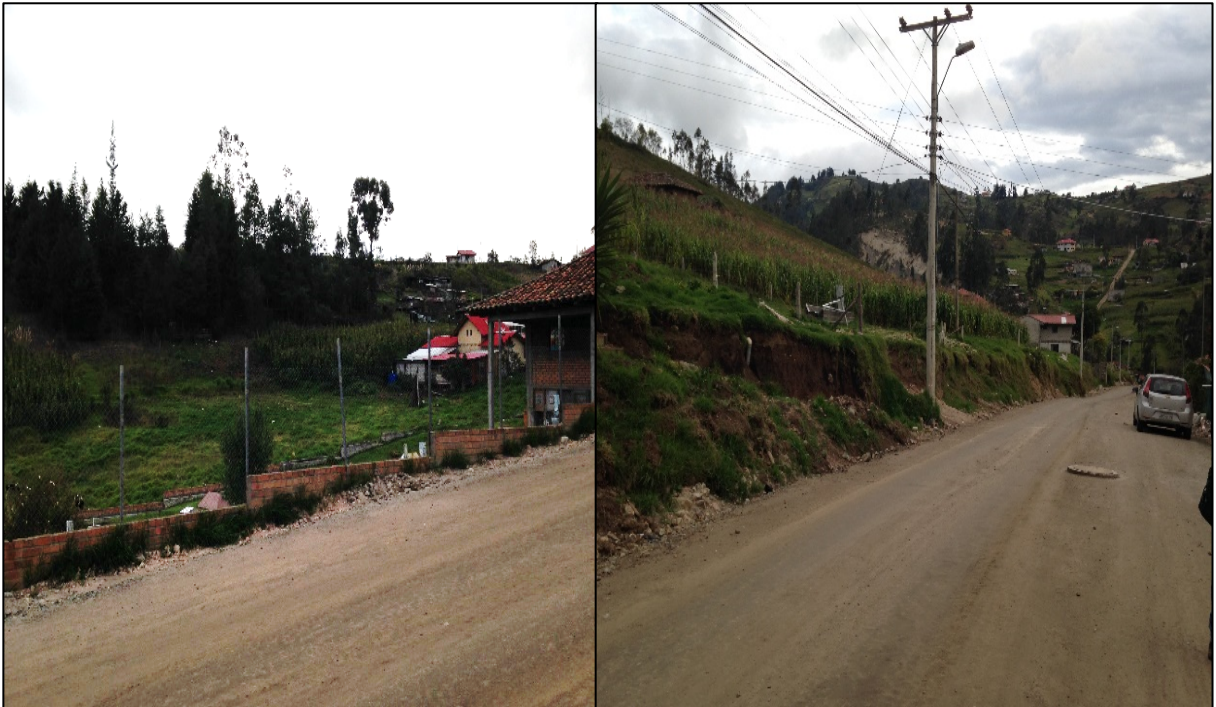
Foto 65 y 66: Obras de instalación de agua potable, luz eléctrica, basureros fijos y alcantarillado
