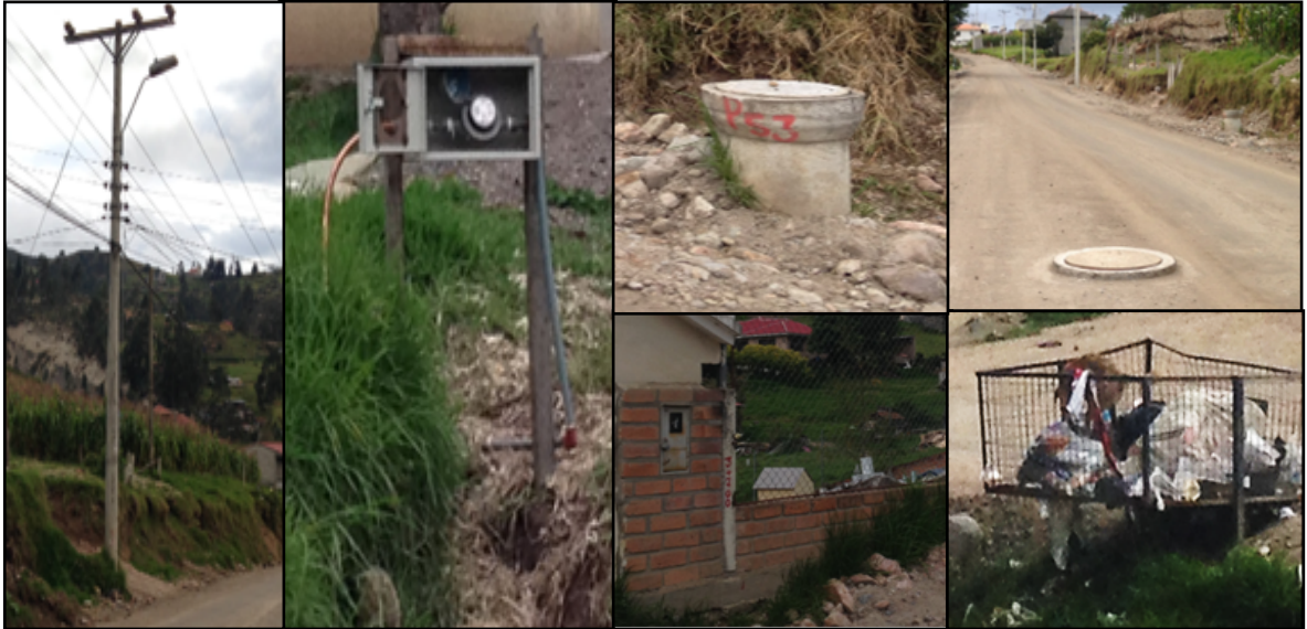
Foto 55 - 60: Obras de instalación de agua potable, luz eléctrica, basureros fijos y alcantarillado Fuente: María Silvana Aroca Amaya
