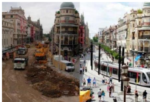
Figura 11. Proceso de adecuación para la peatonalización. Fuente: (Recuperado del Diario Información).
