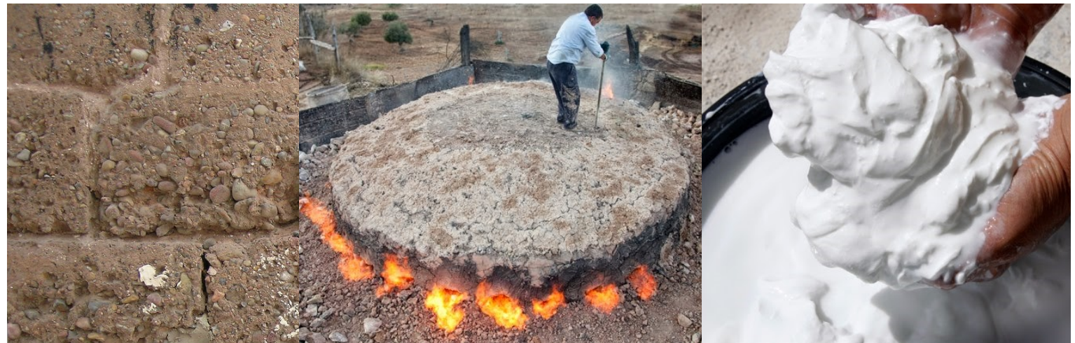
Figura 2: Mortero de arcilla; elaboración de ladrillo de arcilla y mortero de cal
