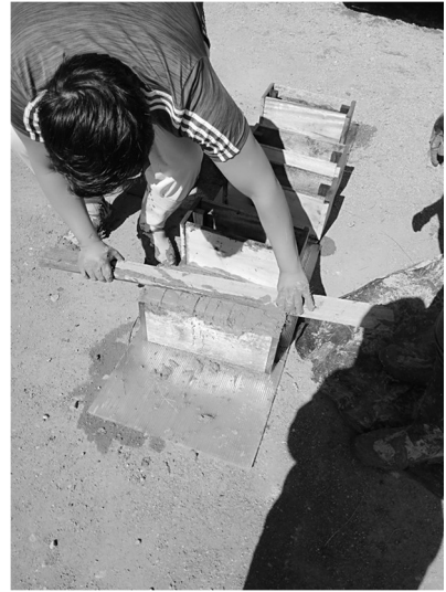
9. Retiro de sobrante de mezcla con una madera
