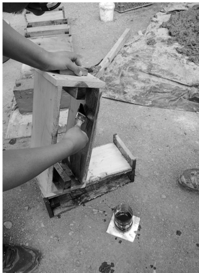
5. Colocación de desmoldante
