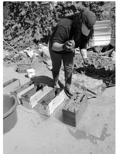
6. Vertido de la mezcla por capas
