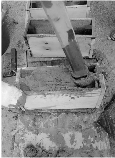
8. Compactado de la mezcla con un palo de madera
