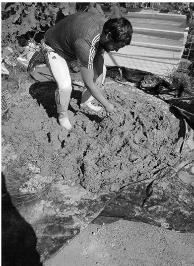
4. Mezclado y reposo de la mezcla
