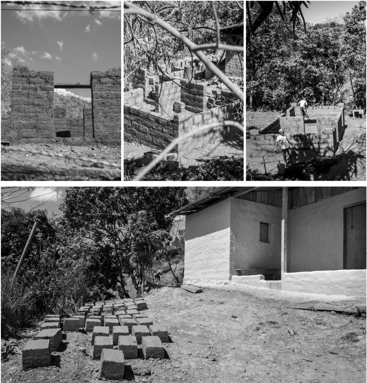
Figura 6: Uso del adobe en la construcción en Jalapa, Nicaragua
