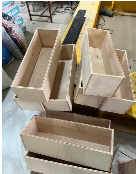
Encofrado para vigas.
