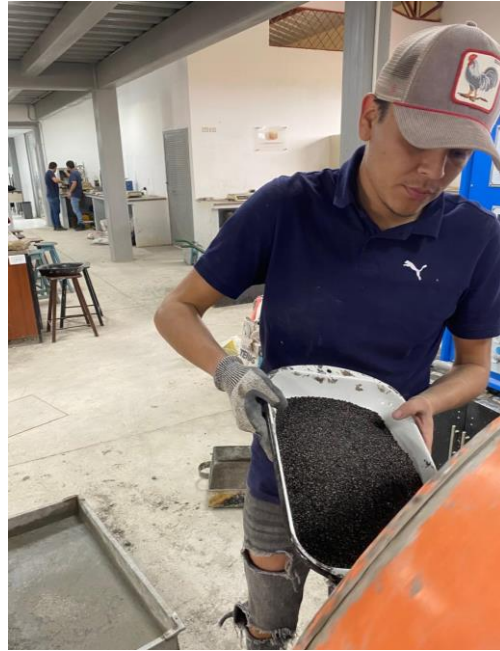
Inclusión de viruta a la mezcla de hormigón.
