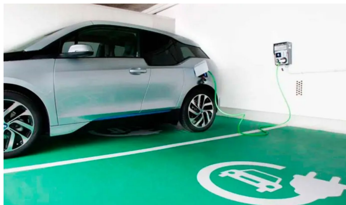
Fig 11. Sistema de Carga Lenta
