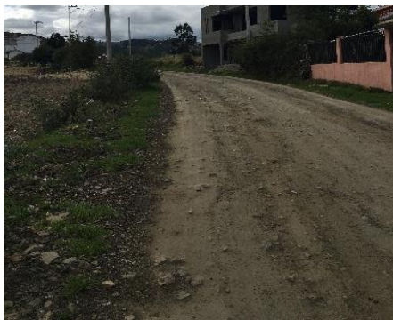
Figura 60: Infraestructura vial. Virgenpamba, Azogues, Ecuador. [Fotografía]. “Elaboración Propia”
