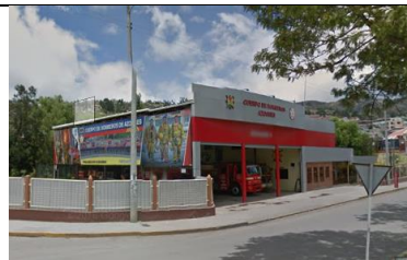
Figura 90: Estación 1 de Bomberos de Azogues, Azogues, Ecuador. [Fotografía]. “Elaboración Propia”
