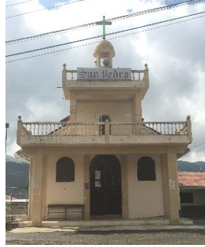
Figura 76: Iglesia de San Pedro. Bellavista, Azogues, Ecuador. [Fotografía]. “Elaboración Propia”
