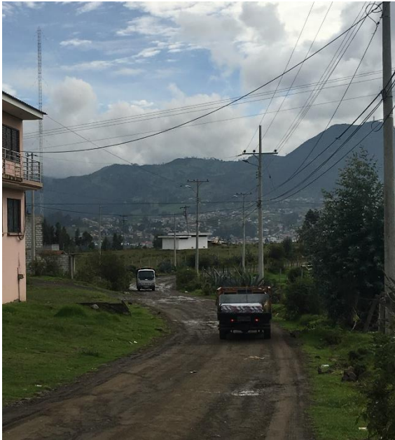
Figura 64: Infraestructura vial. Virgenpamba, Azogues, Ecuador. [Fotografía]. “Elaboración Propia”
