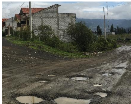
Figura 62: Infraestructura vial. Virgenpamba, Azogues, Ecuador. [Fotografía]. “Elaboración Propia”
