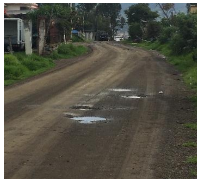
Figura 61: Infraestructura vial. Virgenpamba, Azogues, Ecuador. [Fotografía]. “Elaboración Propia”
