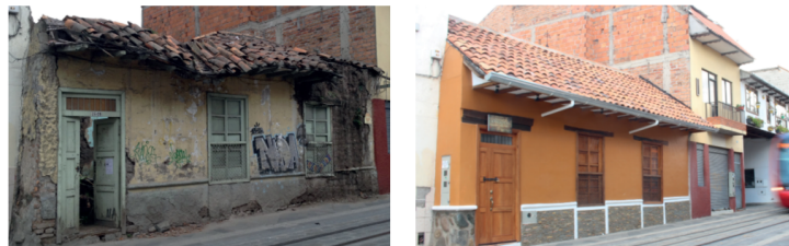
FIGURA 2.3: Ganador de la presea en la categoría readecuación año 2021. Fuente: GAD Municipal de Cuenca (2023). Elaboración: propia.
