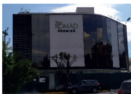
FIGURA 2.11: Ganador de la presea en la categoría Nueva Edificación año 2023. Fuente: GAD Municipal de Cuenca (2023). Elaboración: propia.
