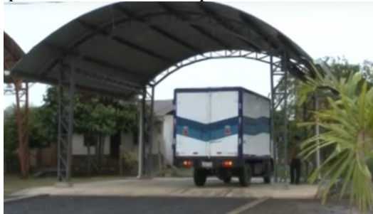
Figura 9: cubierta metálica para la RTV de la Unidad de Tránsito del cantón Sucúa [foto] fuente: (Jara, 2015)
