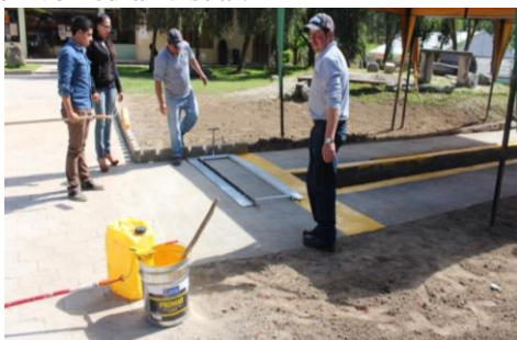
Figura 6: Construcción de la rampa para TRV de vehículos del cantón Guachapala [foto]; Fuente: GAD de Guachapala.
