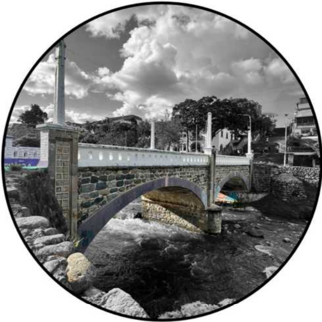
Figura 2.30: Estructura lateral del puente. Fuente y elaboración: Propia.
