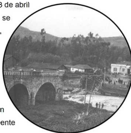
Figura 3.16: Puente Roto (1950). Fuente y elaboración: INCP.
