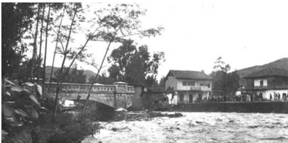
Figura 3.23: "Puente del Vergel" se destruyó el 3 de abril de 1950. Fuente y elaboración: INCP.
