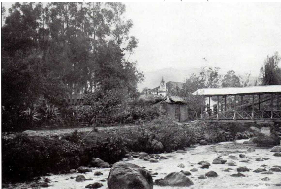
Figura 3.11: Antiguo puente de madera y cubierta de latón. Fuente y elaboración: INCP.
