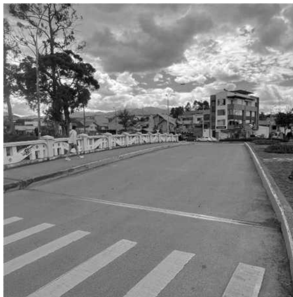
Figura 3.26: Vía de retorno. Fuente y elaboración: Propia.
