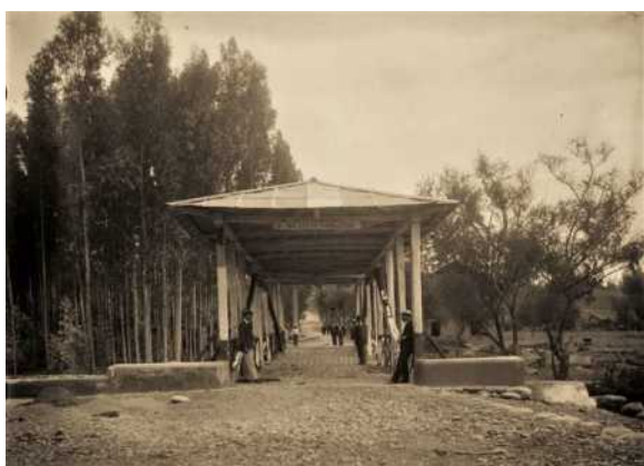
Figura 3.21: "Puente de Ingachaca" se sustituyó en 1930. Fuente y elaboración: INCP.
