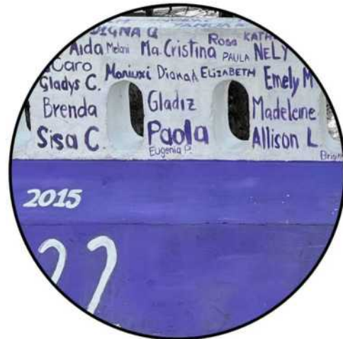
Figura 2.32: Pintura usada para recubrir el puente. Fuente y elaboración: Propia.
