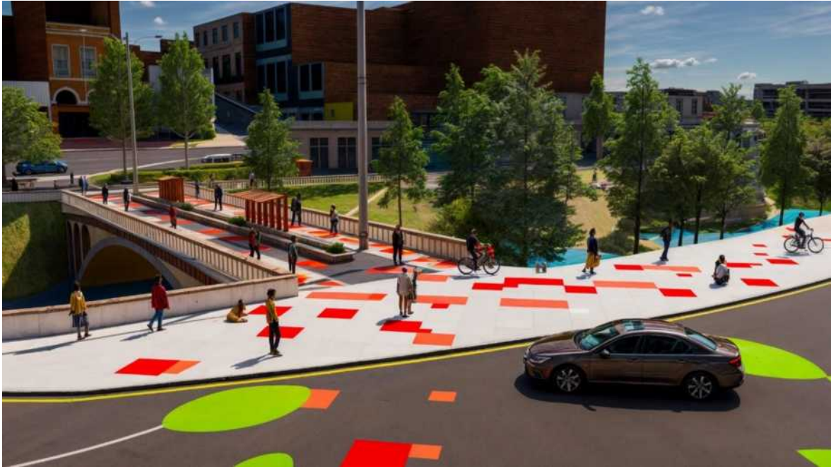
Figura 4.40: Vista del recorrido que forma el andén elevado uniendo toda la acera para una correcta movilidad junto a radios que permiten la continuidad de vehículos. Fuente y elaboración: Propia.
