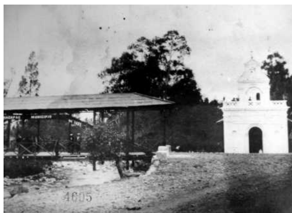
Figura 3.22: "Puente de Ingachaca" se sustituyó en 1930. Fuente y elaboración: INCP.
