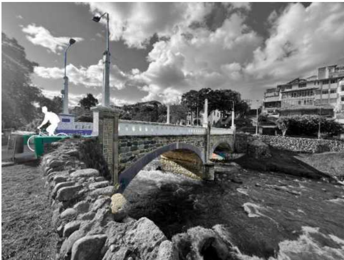
Figura 2.25: Panorámica del puente mostrando su forma estructural de arco. Fuente y elaboración: Propia.
