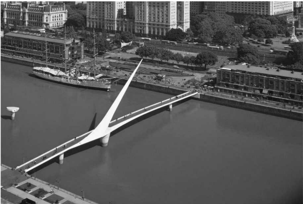
Figura 2.9: Su forma modernista, inspirada en el tango, y su capacidad para girar 90 grados lo convierten en un símbolo de la ciudad y un punto de conexión vital. Fuente y elaboración: https://www.archdaily.co/co/02-66012/clasicos-de-arquitectura-puente-de-la-mujer-santiago-calatrava
