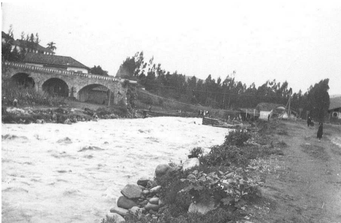
Figura 3.15: Puente provisional. Fuente y elaboración: INCP.
