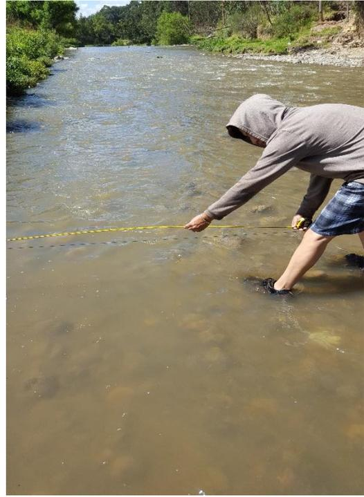
El seccionamiento se realizó cada 5 m y en cada sección se registró las alturas en crecidas
