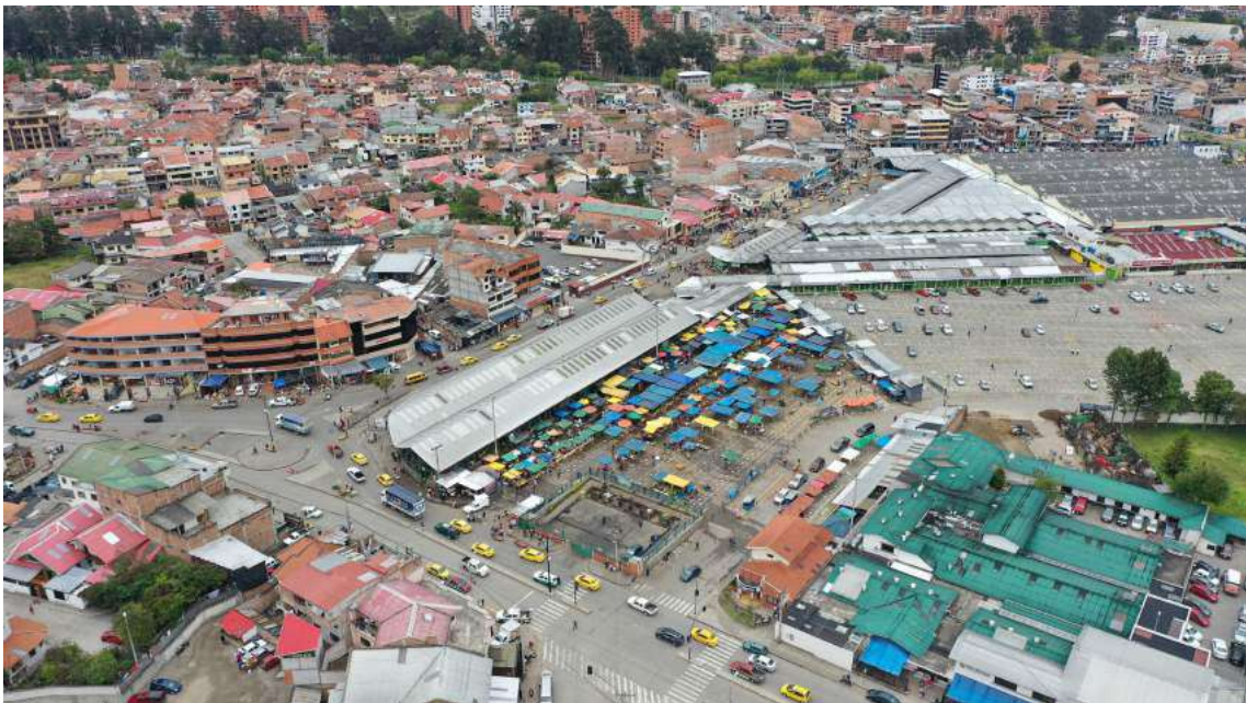
Figura 3.22: Acumulación de basura en el parqueadero que da a la calle Roberto Crespo
