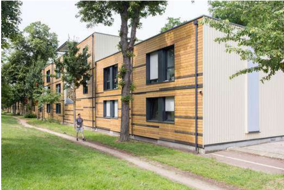
Figura 4.1: Centro de hospedaje de emergencia "Promesa al amanecer".
