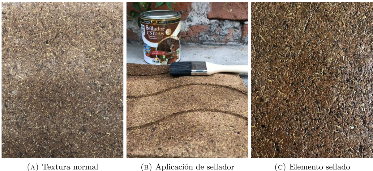
FIGURA 3.6: Impermeabilización con sellador. Fuente: autor
