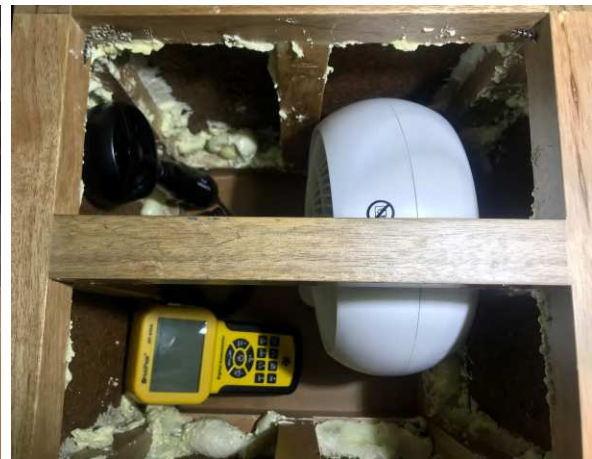
(B) Instalación equipos interior
