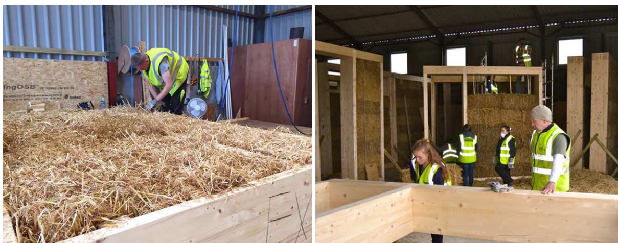
FIGURA 1.3: Paneles modulares prefabricados con paja www.modcell.com
