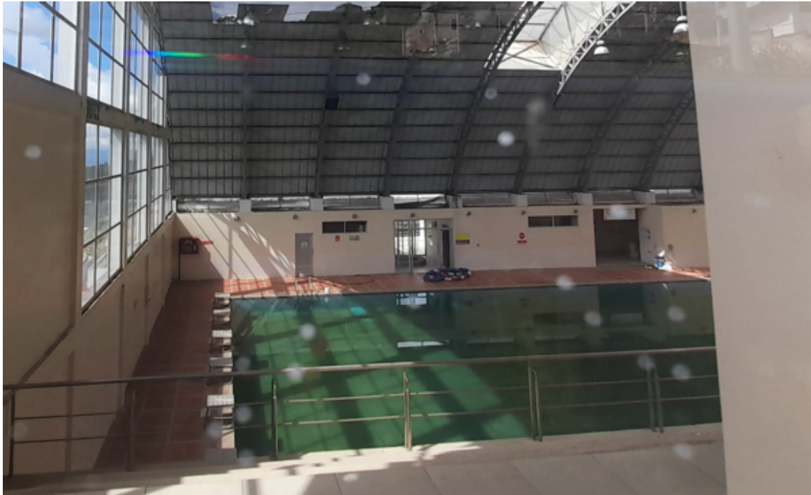
Figura 15: Estado actual de piscina Semi Olímpica
