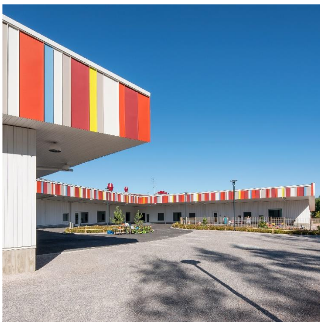
Figura 79 Guardería Painiitty – Espoo, Finlandia
