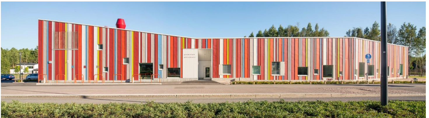
Figura 77 Guardería Painiitty – Espoo, Finlandia
