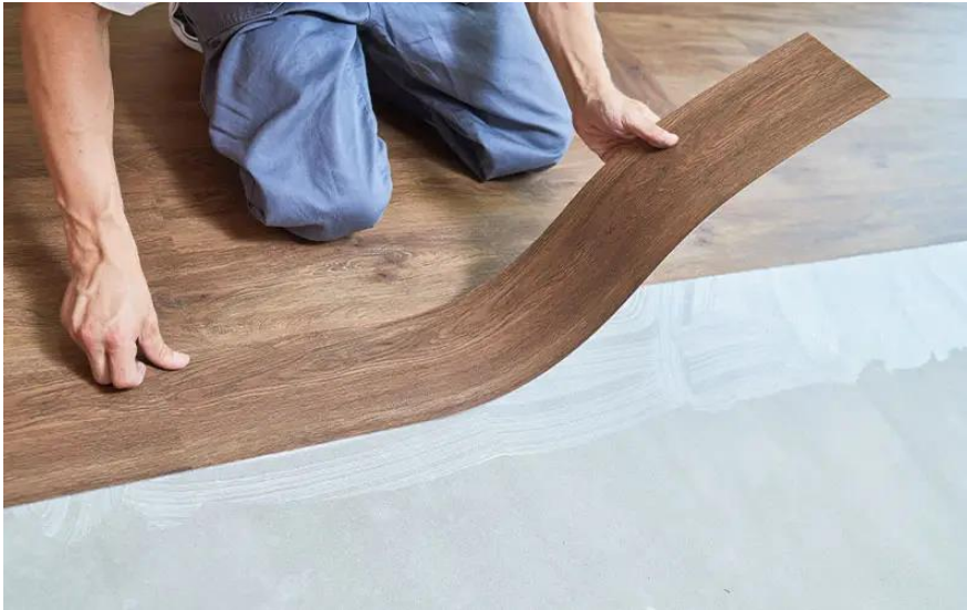
Figura 58 instalación de piso vinílico
