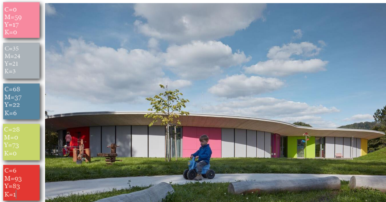
Figura 36 Cromática de la fachada de las Guarderías Semily Treperka y Waldorf, Republica Checa.
