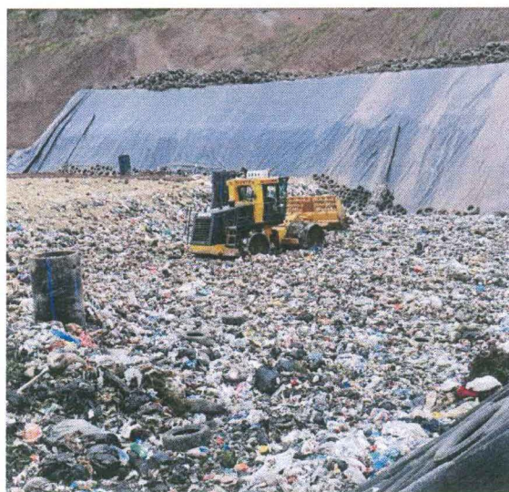
Fig. 1. Maquinaria en relleno sanitario mecanizado Fuente: Autoría propia
