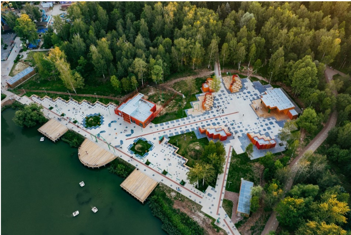
Figura 1.19: Centro cultural y recreativo Gaidar.
