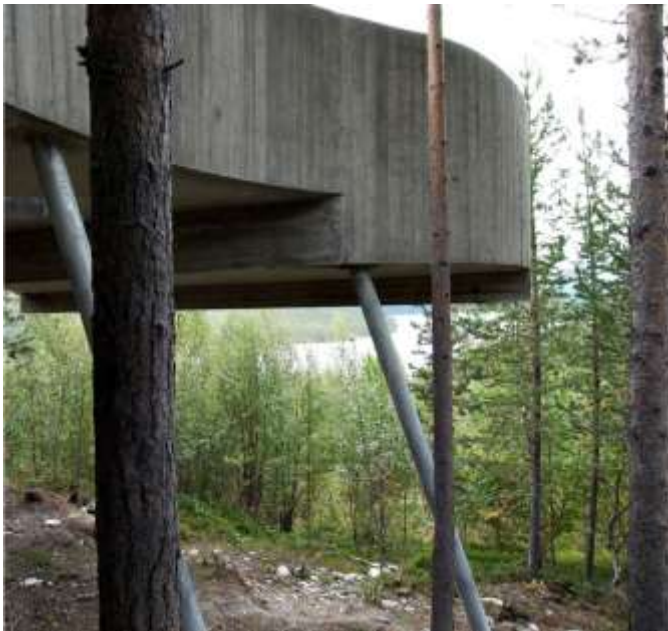
Figura 41. Pilotes acoplado al entorno
