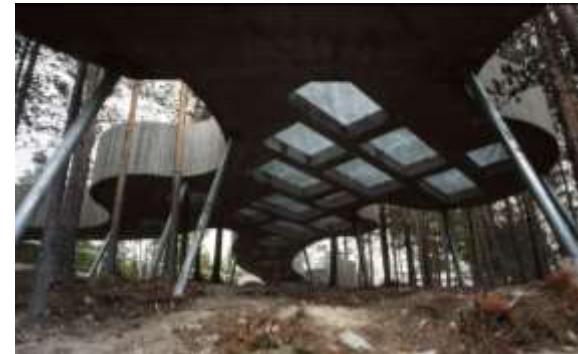
Figura 47. Inclinación de pilotes
