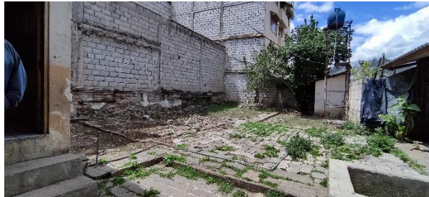
Figura 66: Vivienda 4 (Vista interior) Fuente: Autor de tesis
