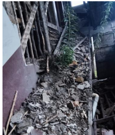
Figura 69: Vivienda 19 (Vista interior) Fuente: Autor de tesis
