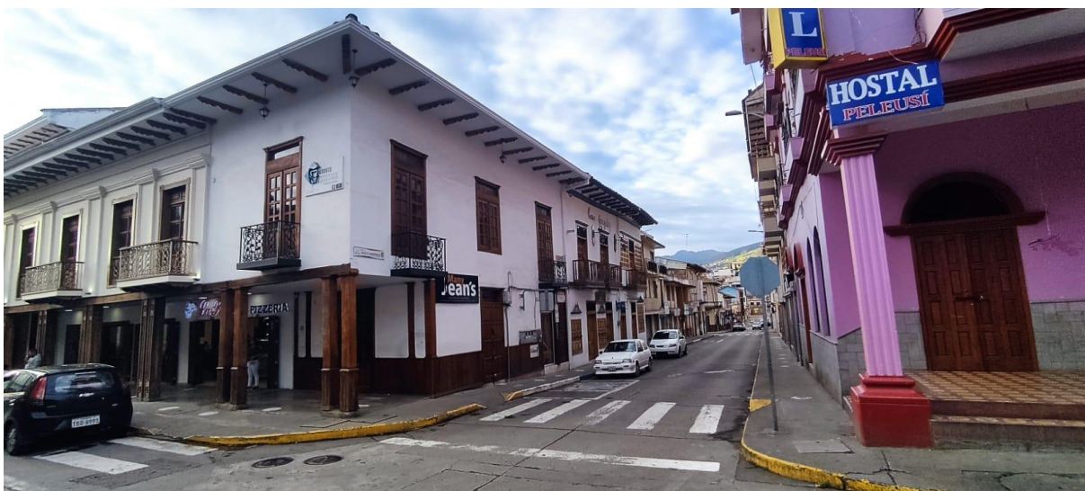
Figura 82: Imagen urbana de las viviendas 10 y 11 Fuente: Autor de tesis
