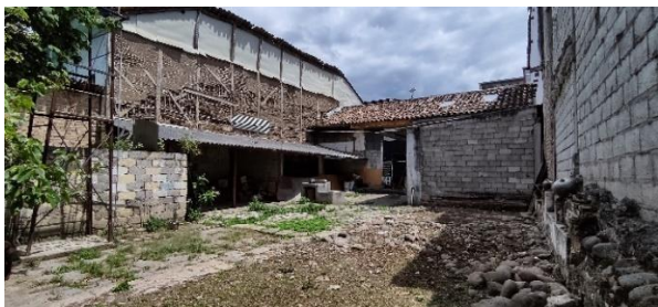
Figura 65: Vivienda 4 (Vista interior) Fuente: Autor de tesis
