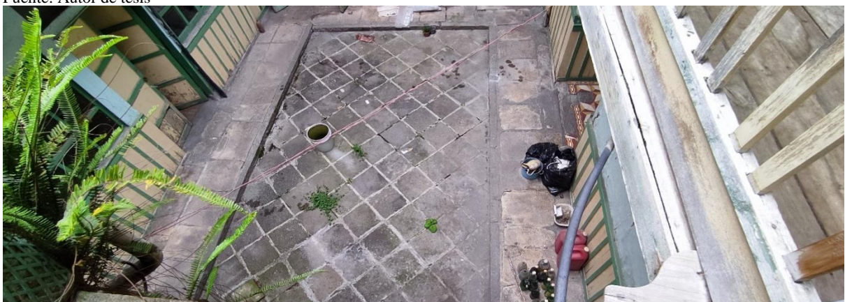
Figura 110: Vivienda 7 (Patio interior) Fuente: Autor de tesis
