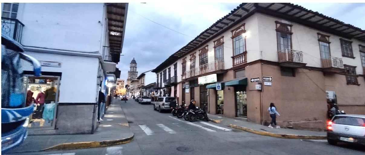
Figura 81: Imagen urbana de las viviendas 1 y 2 Fuente: Autor de tesis
