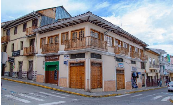
Figura 76: Vivienda 15 (Vista exterior) Fuente: Autor de tesis
