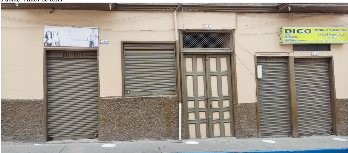
Figura 100: Vivienda 5 (Puertas) Fuente: Autor de tesis
