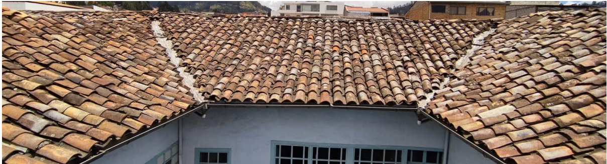
Figura 94: Vivienda 3 (Tejado) Fuente: Autor de tesis
