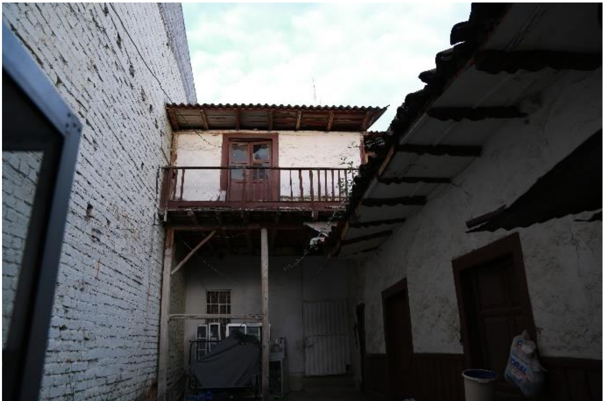
Figura 112: Vivienda 16 (Patio interior) Fuente: Autor de tesis
