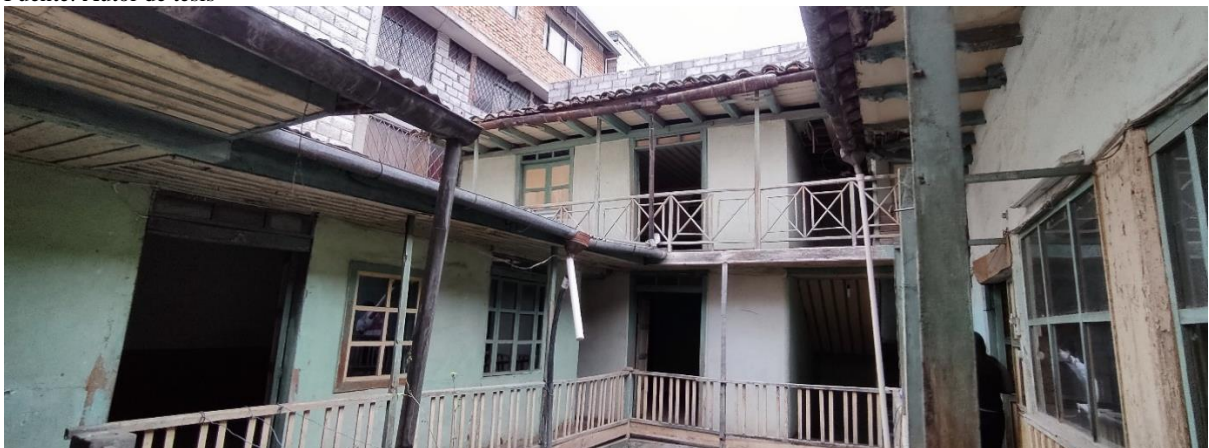
Figura 109: Vivienda 7 (Patio interior) Fuente: Autor de tesis
