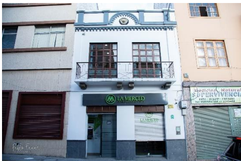
Figura 79: Vivienda 18 (Vista exterior) Fuente: Autor de tesis
