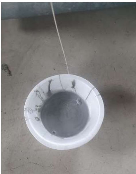
Figura 25. Preparación del aditivo Sikadur.
