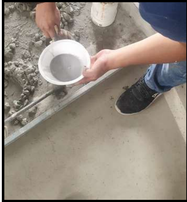
Figura 19. Preparación del aditivo.
