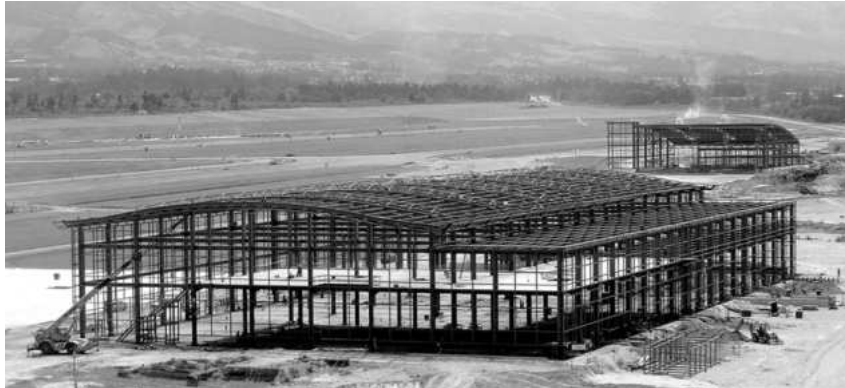
Figura 58: Estructura del aeropuerto proceso de construcción
