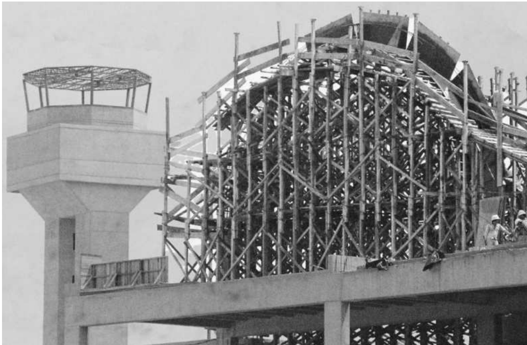
Figura 50: Armado de la estructura del aeropuerto
