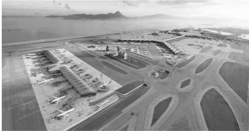
Figura 27: Aeropuerto Internacional de Hong Kong previo a intervención
