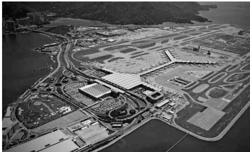
Figura 9: Aeropuerto Internacional de Hong Kong estado actual
