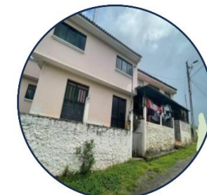
Tema: Edificación 2 Elaboración: Propia
