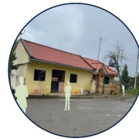
Tema: Edificación 1 Elaboración: Propia
