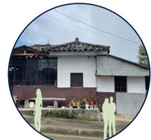
Tema: Edificación 3 Elaboración: Propia
