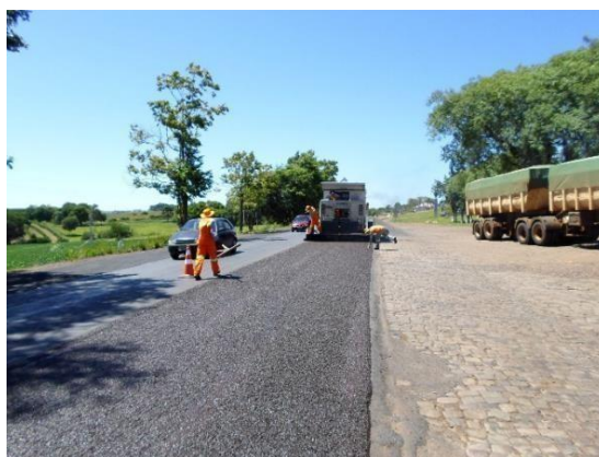
Figura 7. Aplicación de micro pavimento en una vía de Brasil
