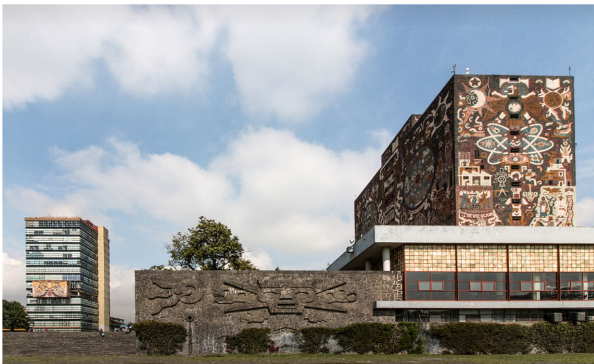
FIGURA 1.2: Edificio Biblioteca Central UNAM. Fuente y elaboración: Adlai Pulido, 2016.
