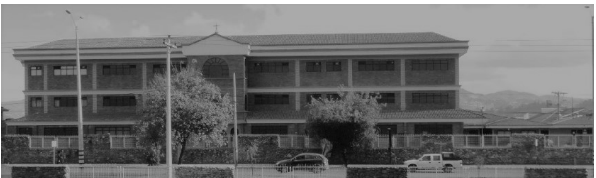
FIGURA 3.32: Edificio UAIIC. Fachada actual desde la Av. de las Américas. Elaborado por: Abad (2015)
