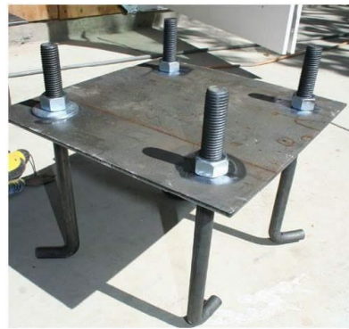
Imagen 8: Placa Base con Pernos de Anclaje
