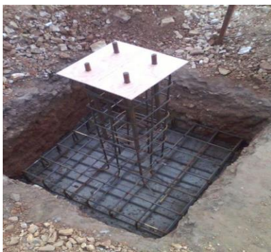
Imagen 7: Conexión Columna – Cimentación
