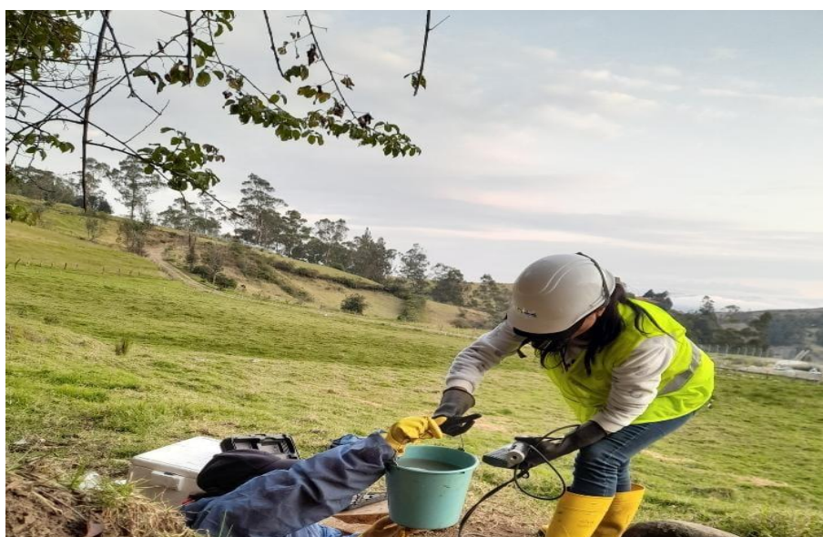
Ilustración 17. Muestreos de las aguas residuales del alcantarillado.
