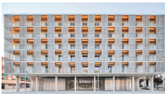
Figura 47: 85 Viviendas Sociales en Cornellà.
