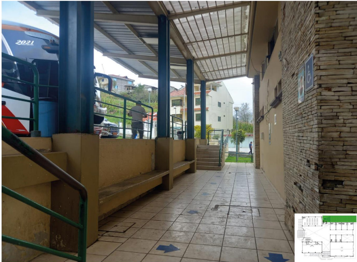
Imagen 82. Zona de andenes
