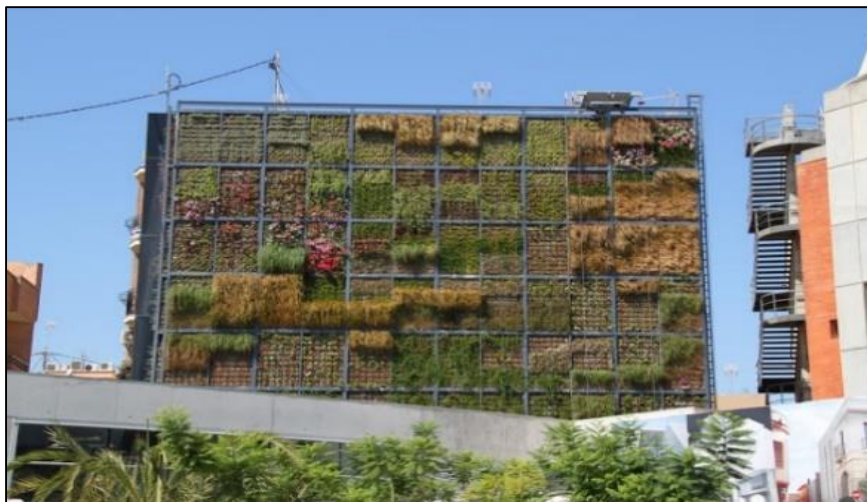
Fig. 63 Sistema de paneles contenedores de sustrato.
