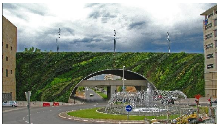
Fig. 55 Muro vertical de Patrick Blanc.
