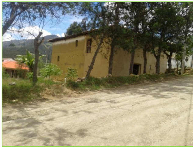
Vivienda rustica dentro del terreno Fig. #16
