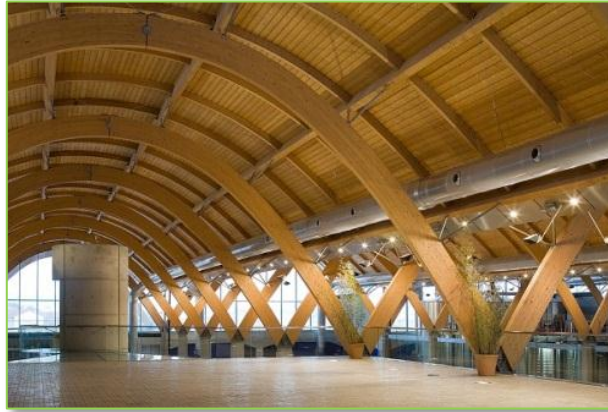
Sistema estructural de la Bodega Protos Fig. # 46
