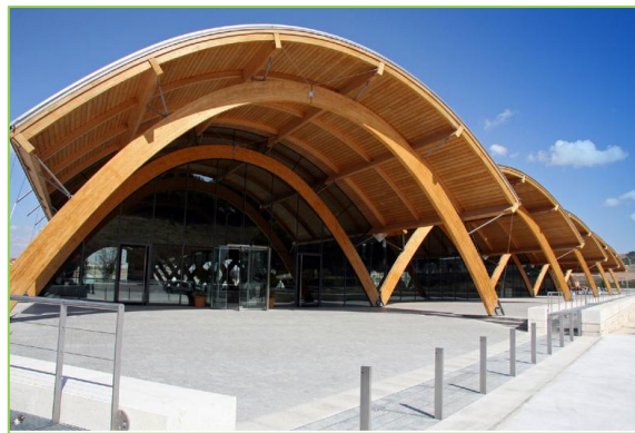
Bodega Protos Fig. # 26
