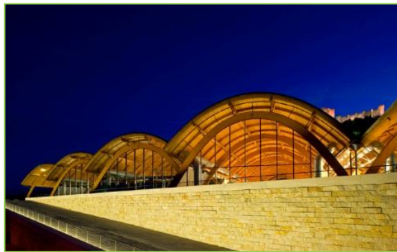
Bodega Protos Fig. # 27
