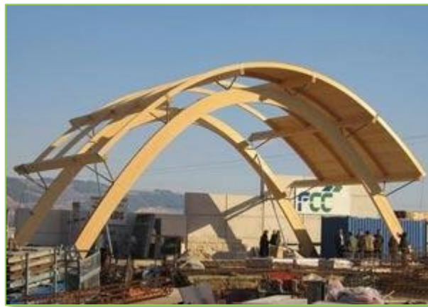
Sistema estructural de la Bodega Protos Fig. # 45
