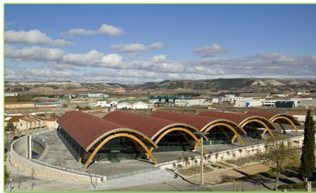
Bodega Protos Fig. # 30
