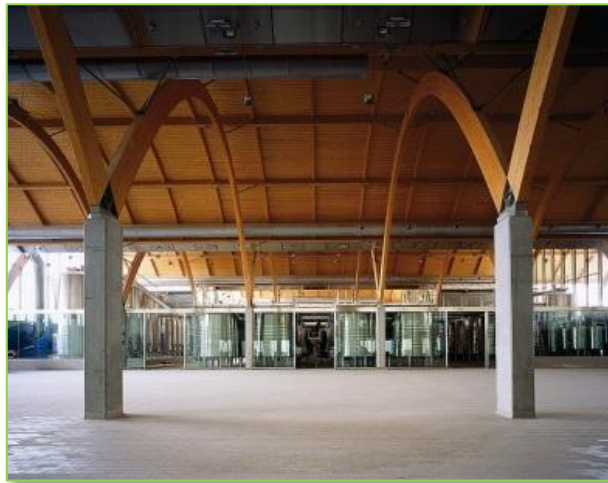
Sistema estructural de la Bodega Protos Fig. # 47
