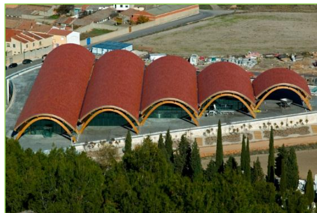
Bodega Protos Fig. # 31
