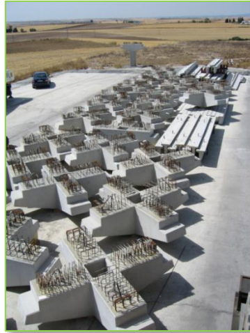
Estructura de hormigón prefabricado de la Bodega Protos Fig. # 44
