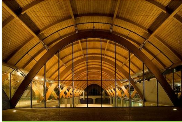
Bodega Protos Fig. # 49
